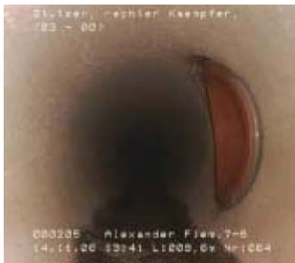
Sanierter Hausanschluss
