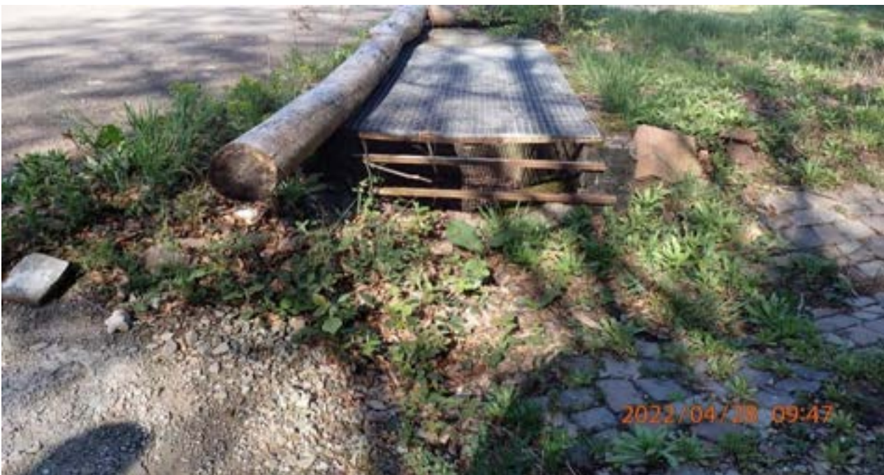
Abb. 60: Entwässerungseinrichtungen am Übergang des Waldwegs auf die Leinigerstraße
