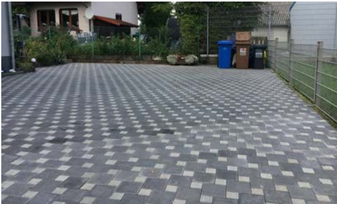
Abb. 32: Beispiel für hohe Flächenversiegelung im Baugebiet Klosterfeld
