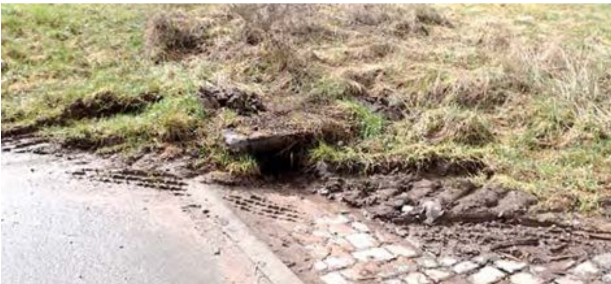
Abb. 48: Verschmutzte Querrinne an der B 48
