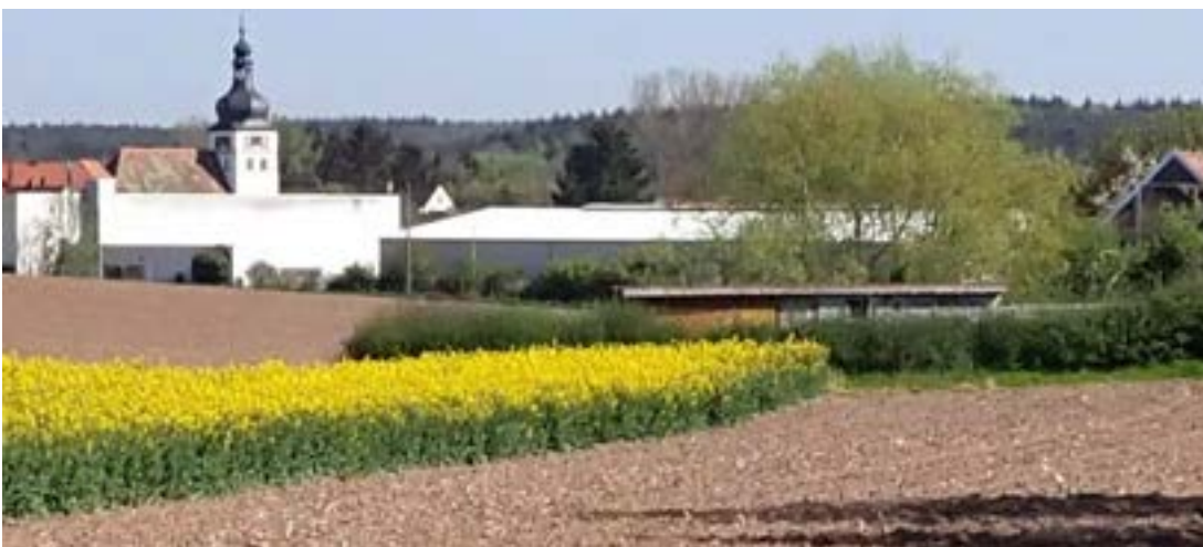
Abb. 75: Überflutungsgefährdete Hallen in der Tiefenlinie
