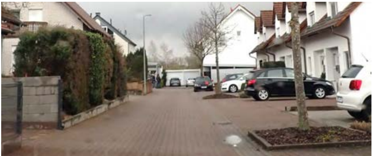
Abb. 7: Abschüssige Straße ohne Notabflussweg
