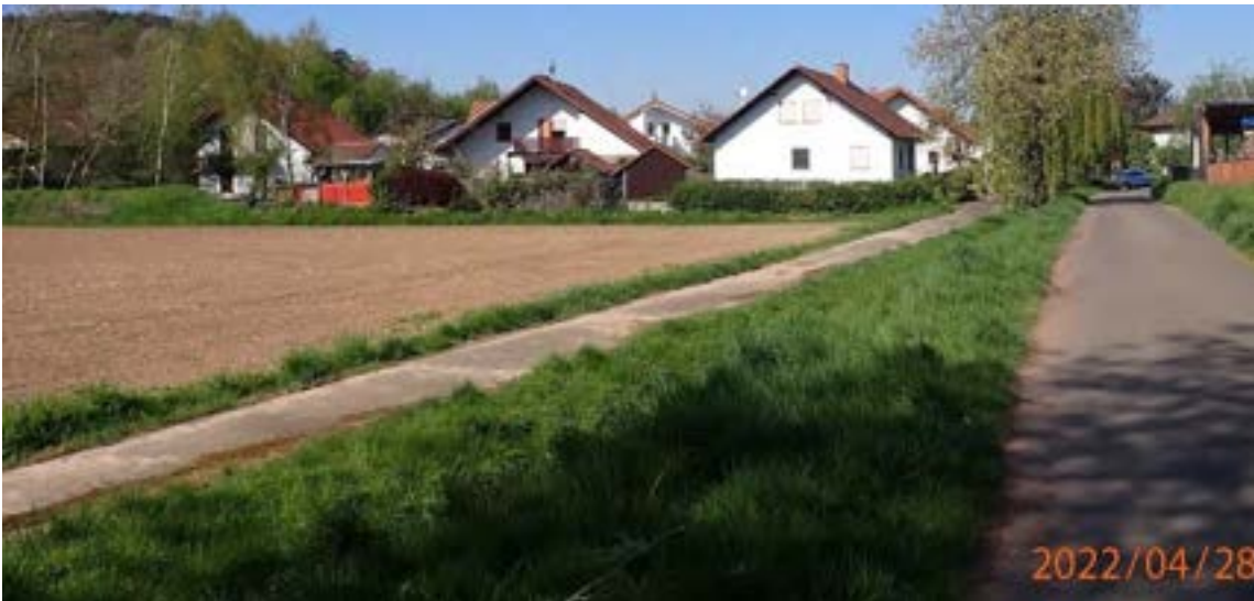
Abb. 54: Überflutungsgefährdeter Bebauungsrand in der Schorlenberger Straße
