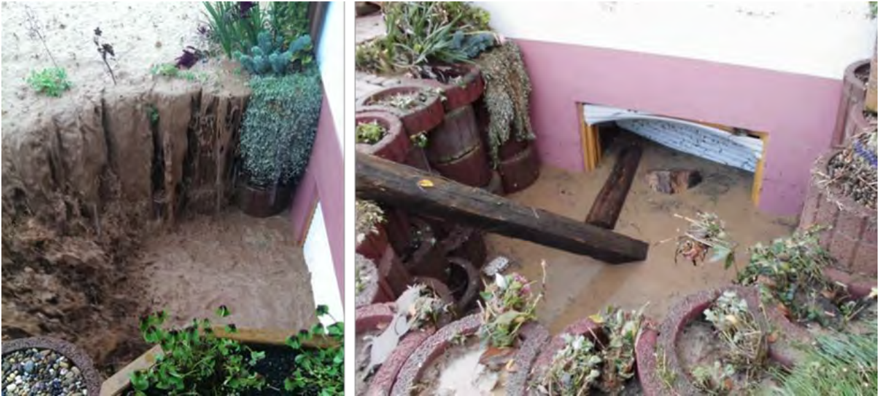
Abb. 15: Überflutete Souterrainwohnung im Moscheltal 2014
