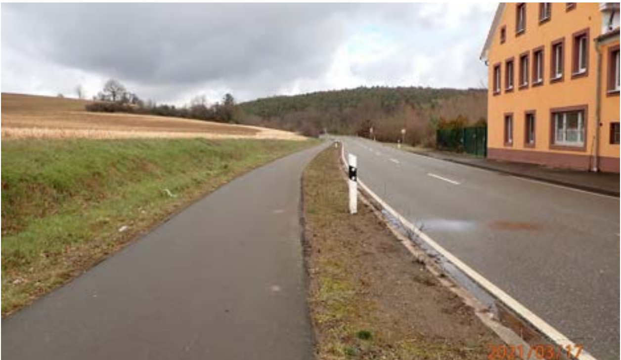
Abb. 44: B 48 mit schwach bzw. nicht ausgebildetem Seitengraben
