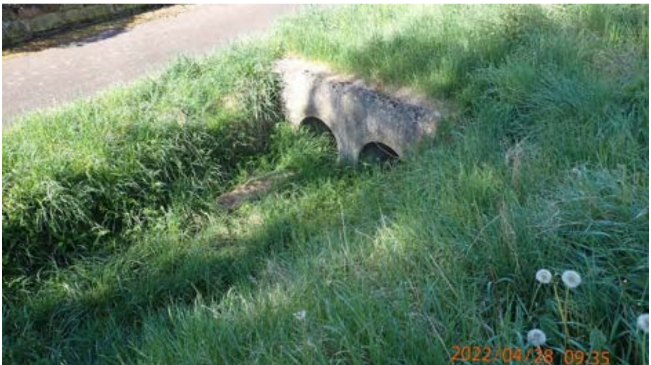
Abb. 53: Ende des Flutgrabens und Beginn der Verrohrung zur Alsenz
