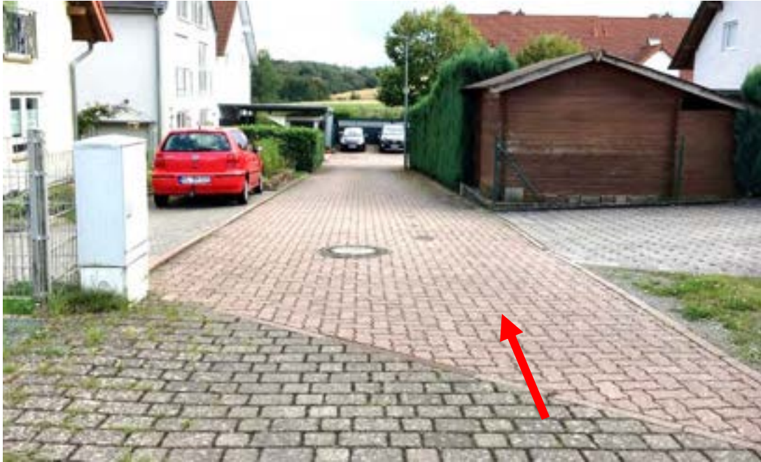
Abb. 31: Abschüssige Straße „Im Klosterfeld“ mit Gebäuden als Abflussbarriere im Tiefpunkt
