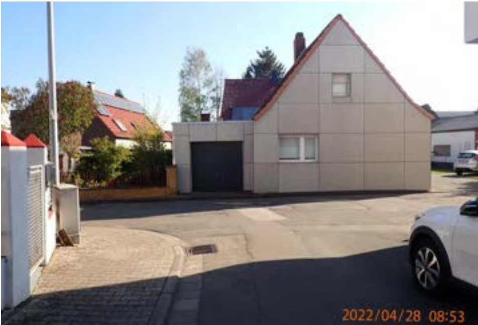
Abb. 29: Tiefpunkt der Welschgasse mit überflutungsgefährdeter Bebauung
