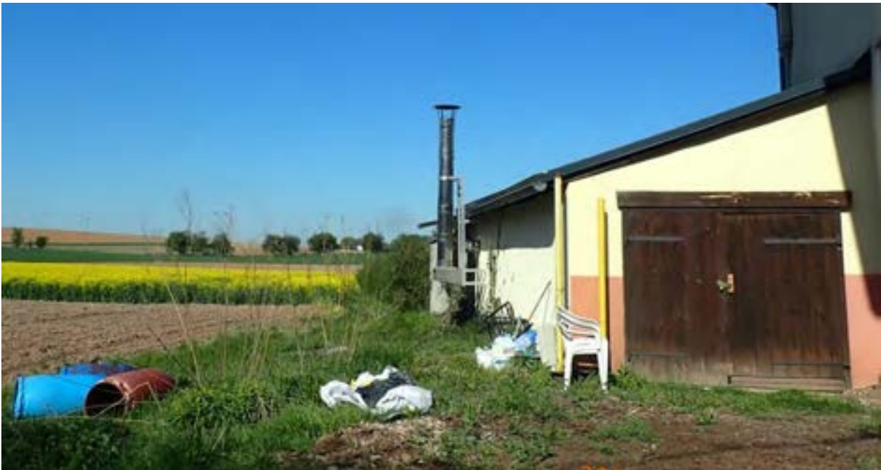
Abb. 72: Überflutungsgefährdeter Bebauungsrand der Herlenbergstraße
