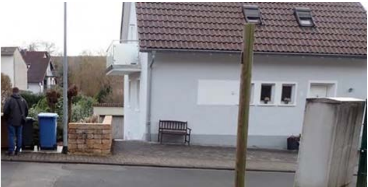
Abb. 98: Überflutungsgefährdetes Haus in der Abflusslinie
