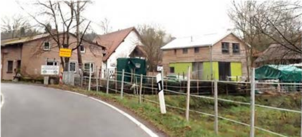
Abb. 102: Potenziell überflutungsgefährdete Gebäude in der Talsohle
