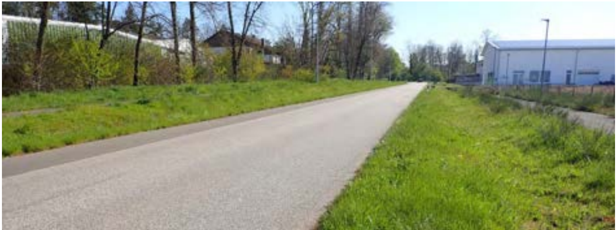
Abb. 23: Versickerungs- und Retentionsmulde zwischen Kaiserslauterer Straße und Radweg
