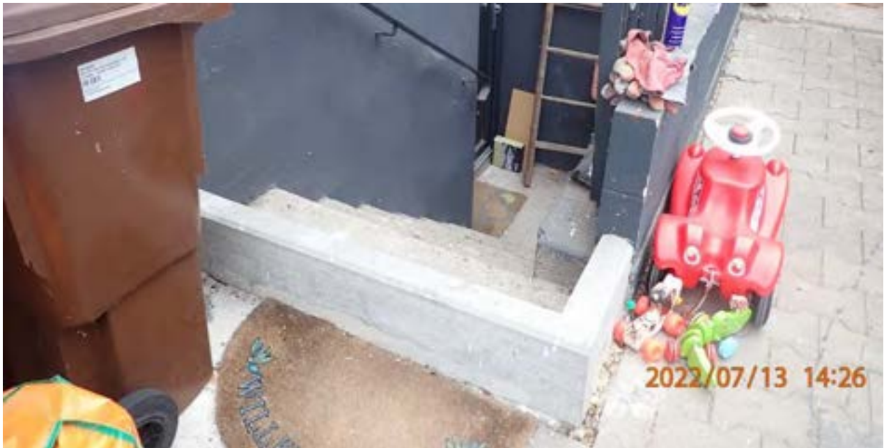
Abb. 18: Beispiel für die Sicherung eines außenliegenden Kellerzugangs
