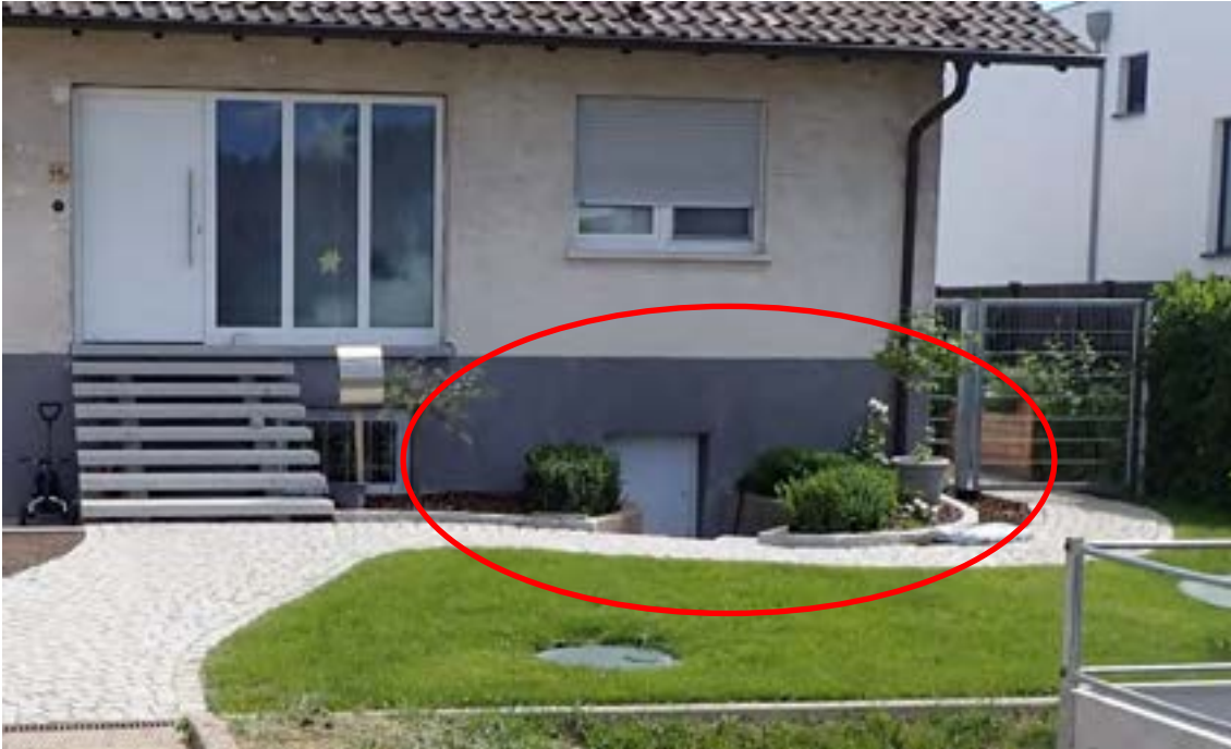
Abb. 13: Untergeschoss mit außenliegendem Zugang
