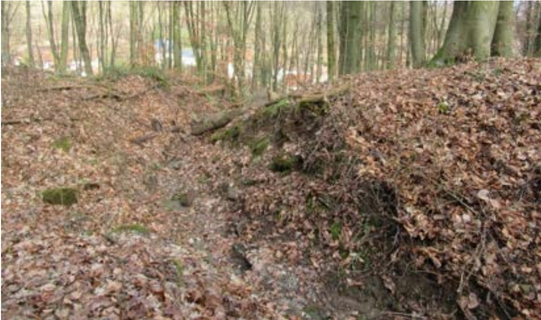
Abb. 9: Beispiel für einen Querabschlag von einem Waldweg in die Fläche
