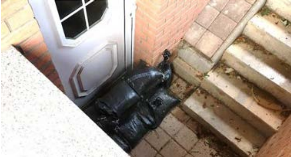
Abb. 35: Provisorischer Objektschutz im Klosterfeld
