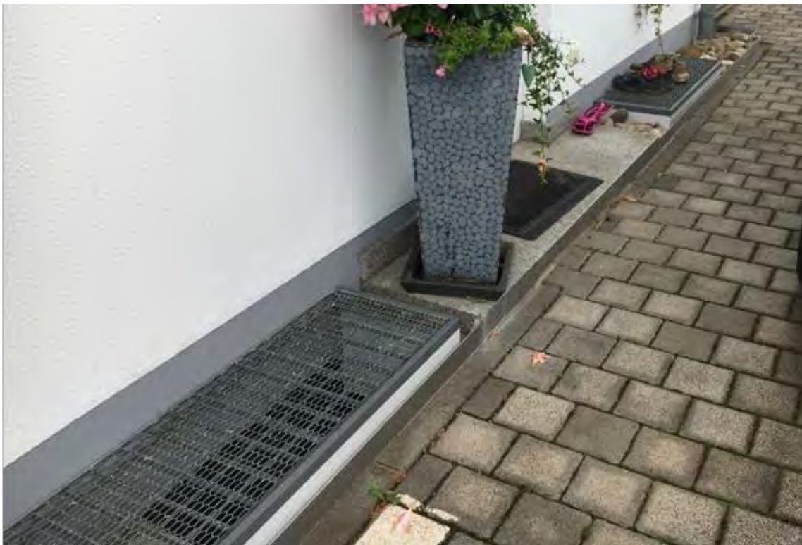
Abb. 34: Aufkantung (Edelstahlblech) an Lichtschacht
