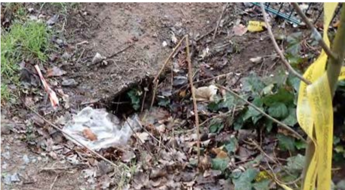
Abb. 96: Verlegtes Zulaufbauwerk zum Regenwasserkanal
