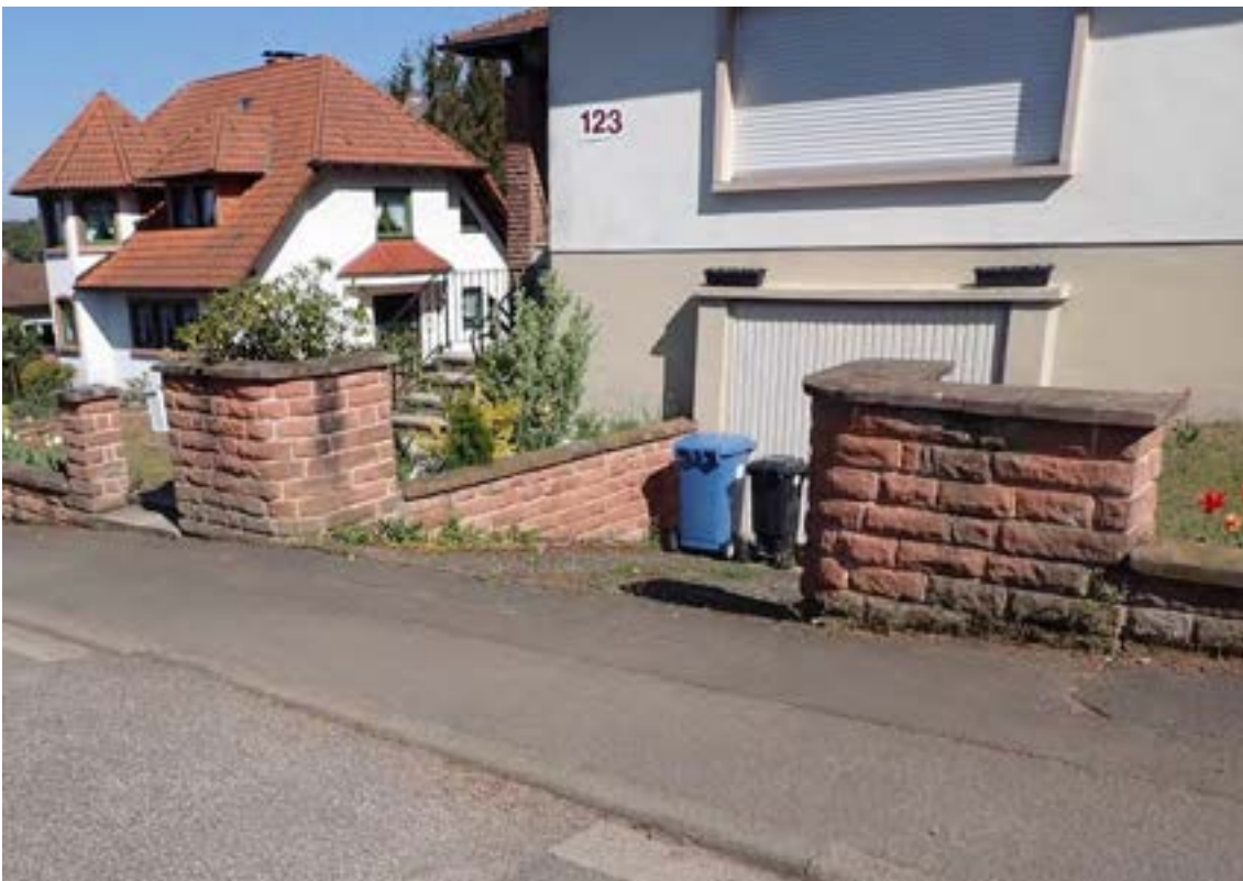
Abb.: 14: Abschüssige Garagenzufahrt
