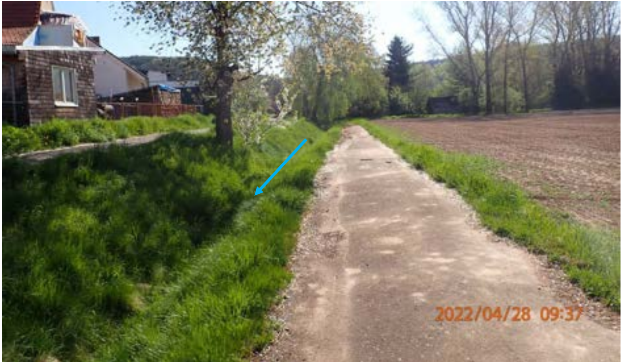
Abb. 52: Flutgraben vom RRB zur Verrohrung in die Alsenz
