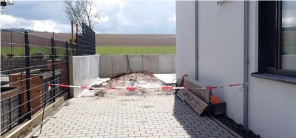
Abb. 82: Neue Randbebauung mit Einfriedungsmauer über dem Gelände
