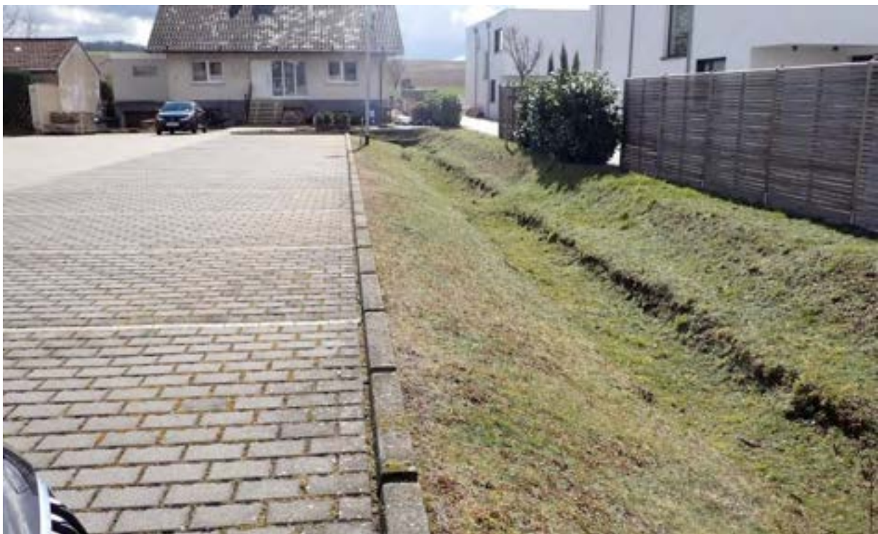
Abb. 85: Sickermulde zwischen Parkplatz und Anliegerstraße
