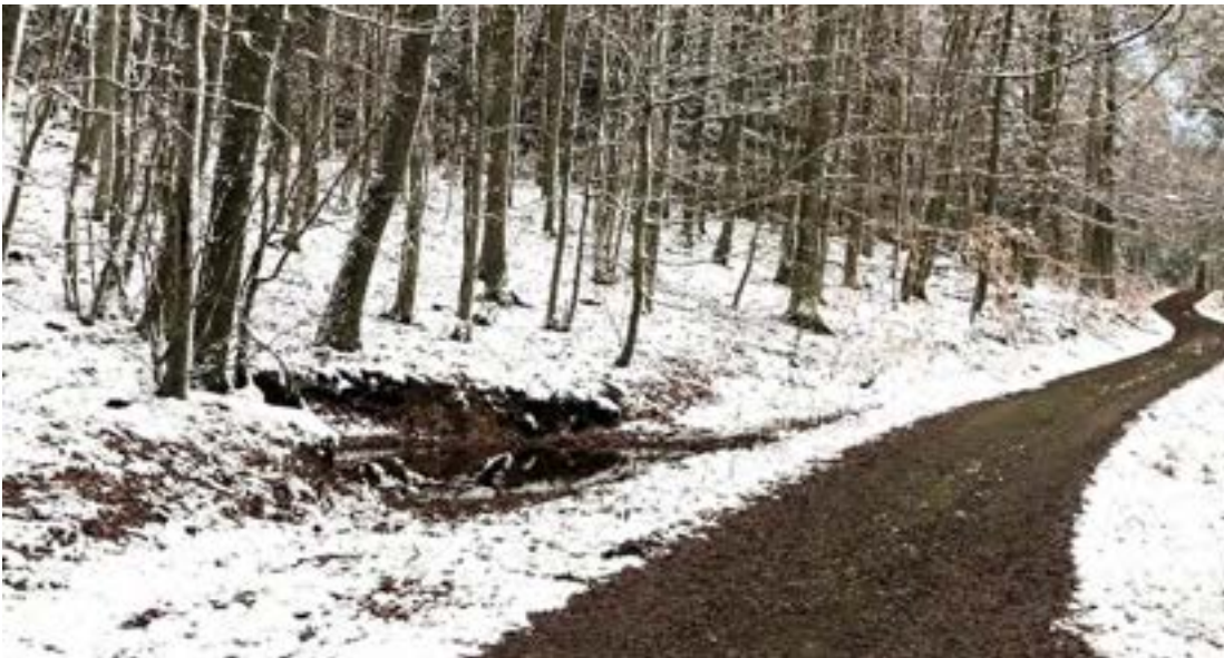
Abb. 10: Kleinrückhalt als Sickermulde neben einem Waldweg
