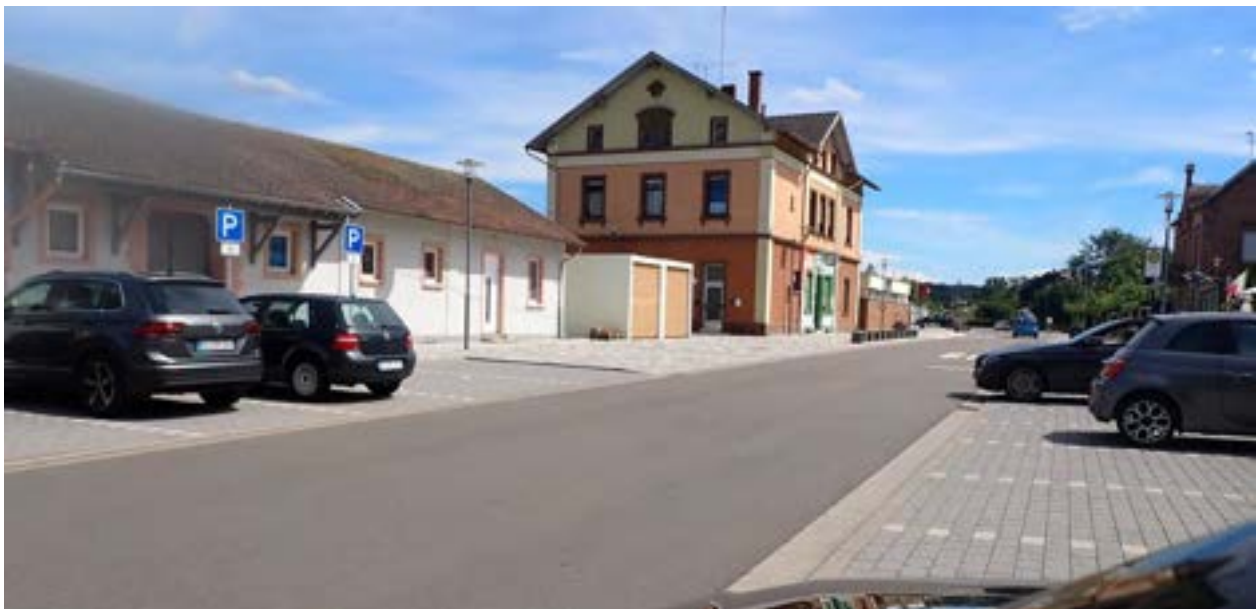
Abb. 41: Potenziell überflutungsgefährdete Bebauung in der Bahnhofstraße
