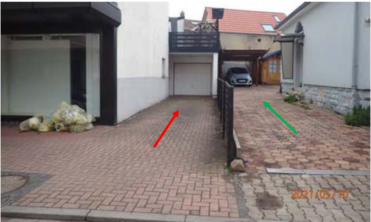
Abb. 16: Überflutungsfördernde (rot) und überflutungsangepasste Bauweise (grün)
