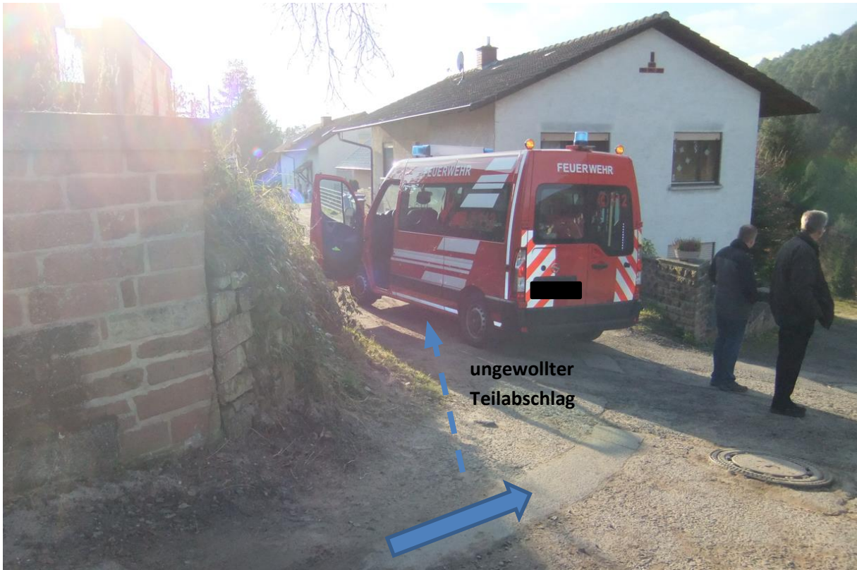
Abbildung 12: Einmündungsbereich mit fehlerhafter Abflusslenkung, Teilabschlag mit Einstau in Stichstraße
