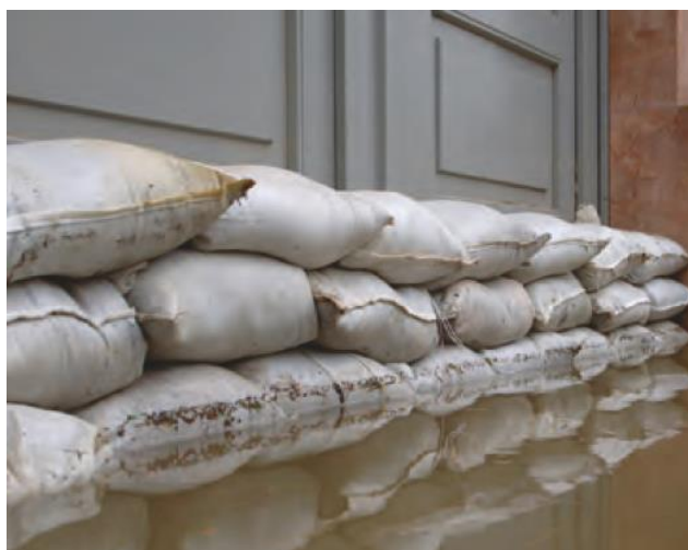
Abbildung 18: Notfallmäßiger Objektschutz mit Sandsäcken [Hochwasserschutzfibel]
