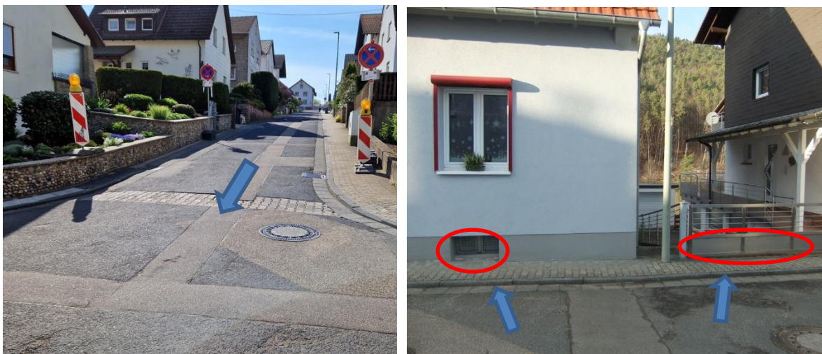
Abbildung 40: Blick Richtung Gartenstraße (links), tief liegende Gebäudeöffnung und Garage als Gefahrenpunkt (rechts)
