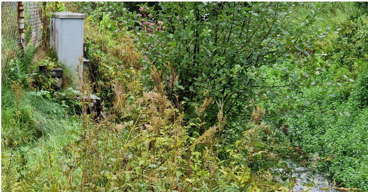
Abbildung 21: Verteilerkasten direkt im überflutungsgefährdeten Bereich am Gewässer in der Ortslage Elmstein
