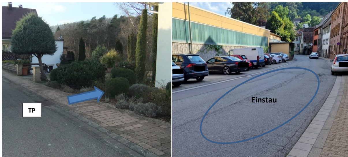
Abbildung 10: Tiefpunkt mit Abflussweg durch Bebauung (links), Tiefpunkt mit Einstaubereich, bedingt durch beidseitige dichte Bebauung und keinem direkten Abflussweg (rechts)
