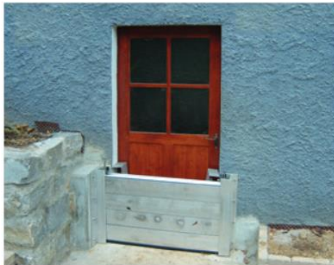
Abbildung 17: Objektschutz an Gebäudeöffnungen [Hochwasserschutzfibel]
