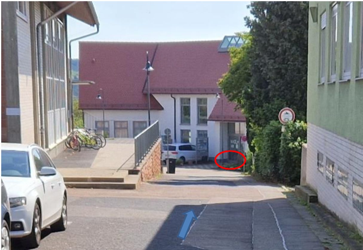
Abbildung 36: Straßenkörper Richtung Dorfgemeinschaftshaus als NA-Weg, mit Eingang Dorfgemeinschaftshaus als gefährdete Stelle
