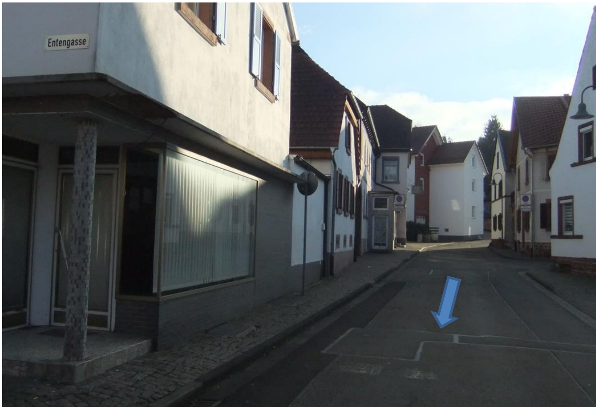
Abbildung 35: Blick entlang der Hauptstraße (NA-Weg) entgegen Fließrichtung oberflächlich abfließendes Wasser
