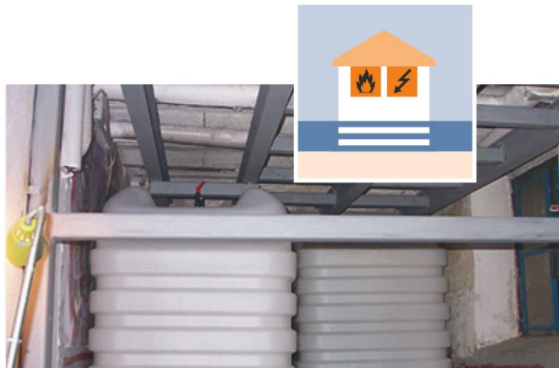
Abbildung 15: Strategie Anpassen, hier durch Sicherung gefährdeter Tankanlagen [Hochwasserschutzfibel]
