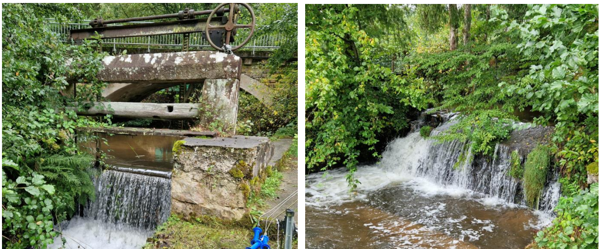
Abbildung 45: Wehranlage in Erfenstein (links) mit Überlauf (rechts)
