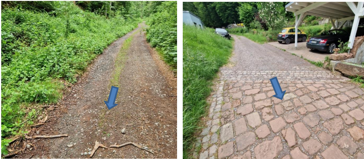
Abbildung 48: Erfensteinertal oberhalb Bebauung (links), Ausbauende Schankentalstraße (rechts)
