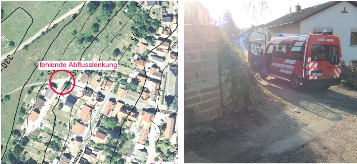
Abbildung 41: Bereich fehlende Abflusslenkung in der Bergstraße (links), Blick auf nicht ausgebauten Einmündungsbereich (rechts)
