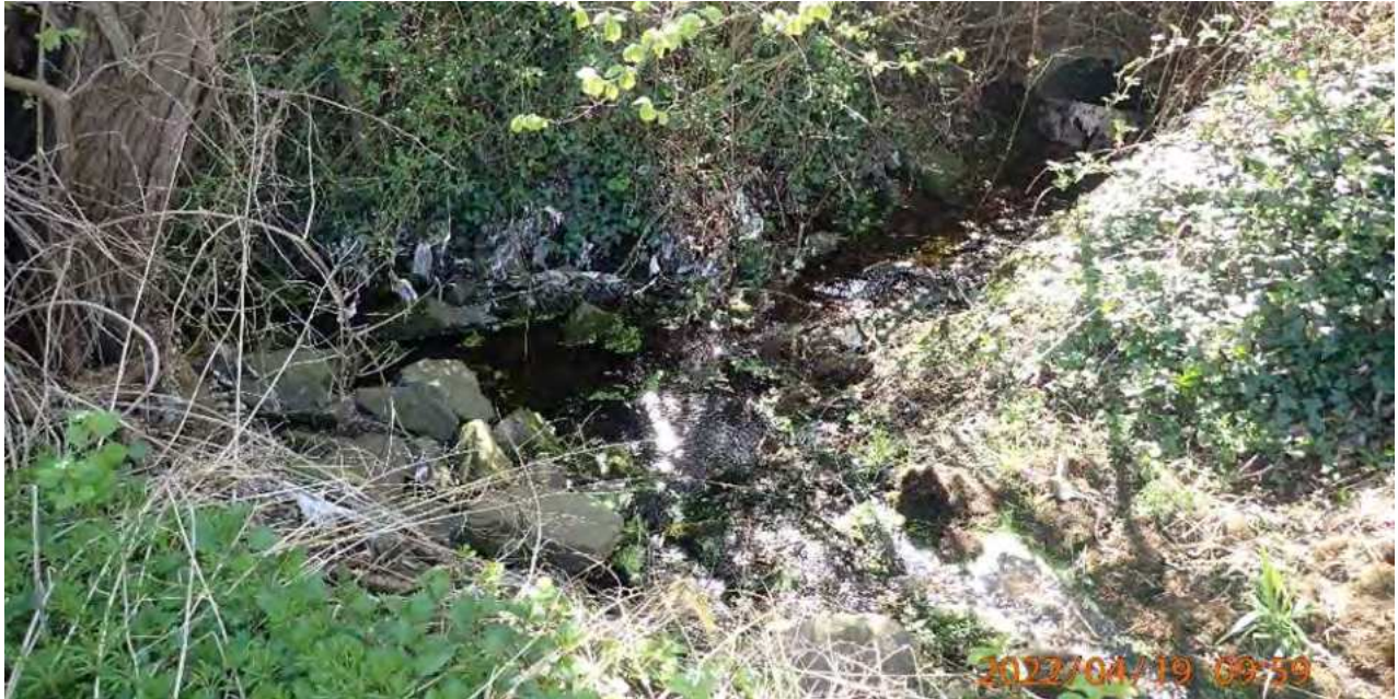
Abb. 42: Einleitstelle der Regentlastung des RÜB in den Erdpfuhlgraben
