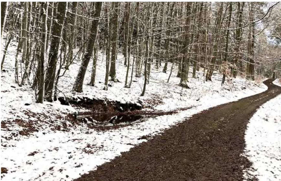
Abb. 9: Kleinrückhalt als Sickermulde neben einem Waldweg
