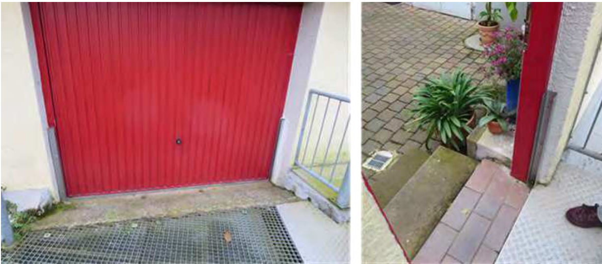
Abb. 20: U-Schienen für Dammbalkenverschlüsse
