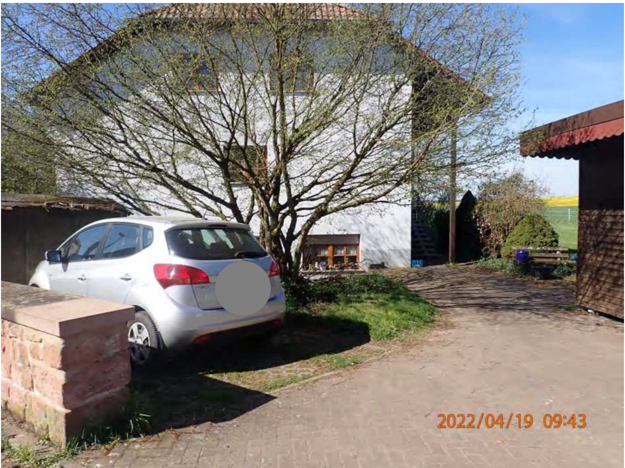
Abb. 84: Überflutungsgefährdete Bebauung auf dem Mehlingerhof
