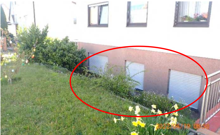
Abb. 13: Beispiele für überflutungsgefährdete Untergeschosse
