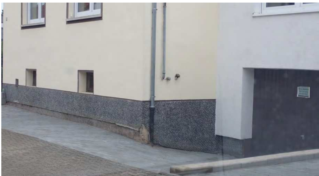
Abb. 24: Beispiele für überflutungsgefährdete Untergeschosse
