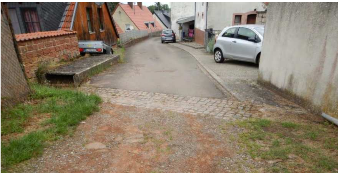
Abb. 63: Querrinne mit Sandfang in der oberen Bornstraße
