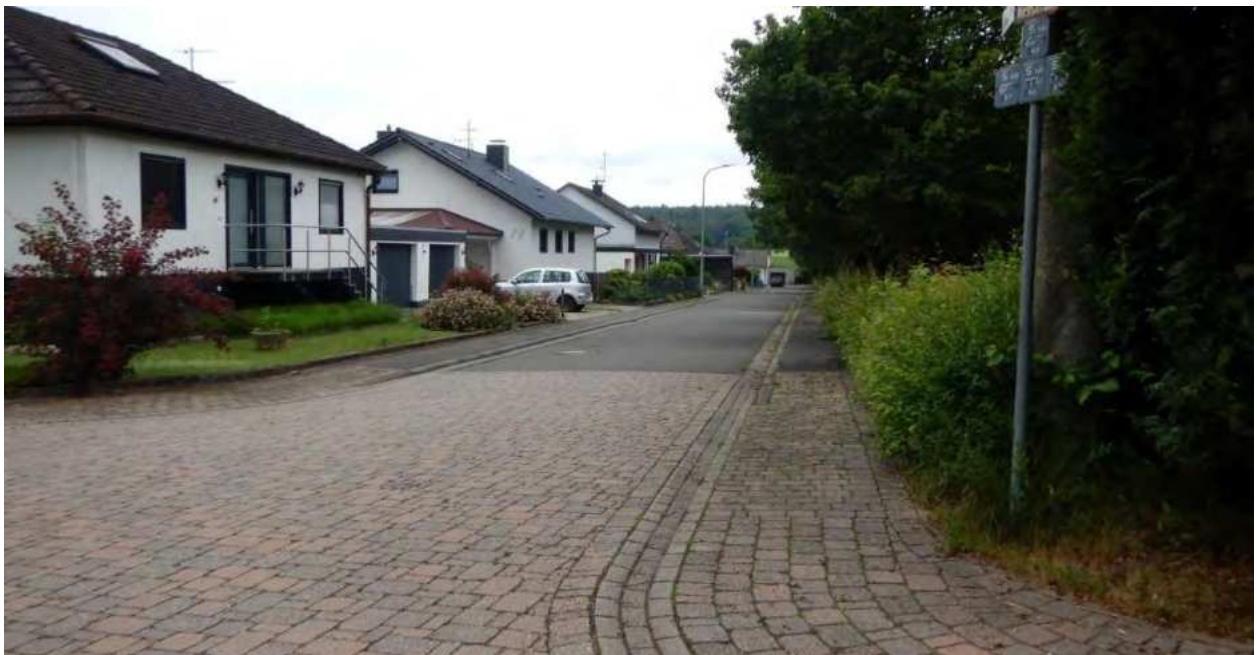
Abb. 75: Überflutungsgefährdete Bebauung in der Baumgartenstraße
