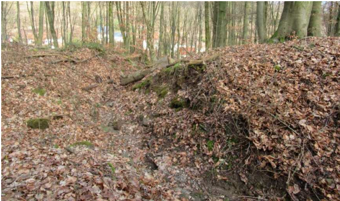
Abb. 8: Beispiel für einen Querabschlag von einem Waldweg in die Fläche
