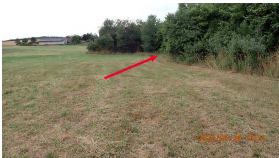
Abb. 67: Tiefpunkt am Lärmschutzwall
