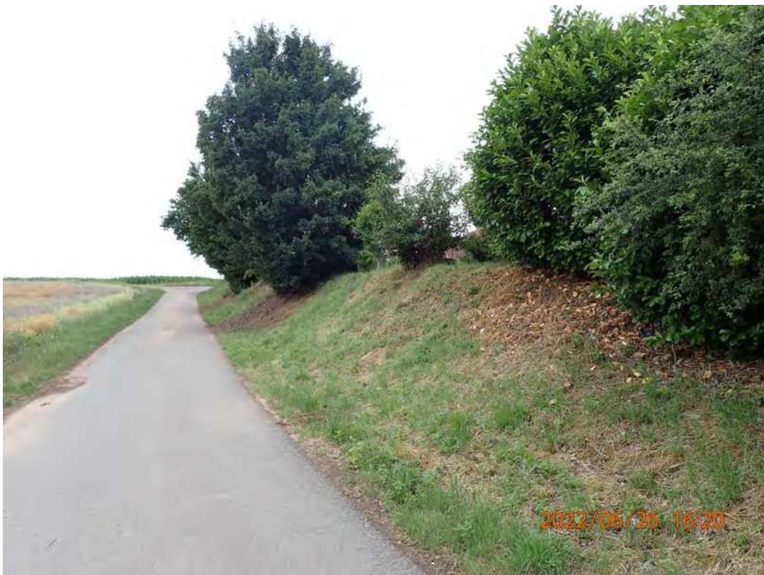
Abb. 71: Weg entlang des Lärmschutzwalls Katerloch
