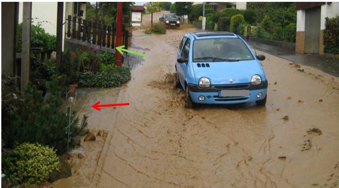
Abb. 16: Überflutungsfördernde (rot) und überflutungsangepasste Bauweise (grün)
