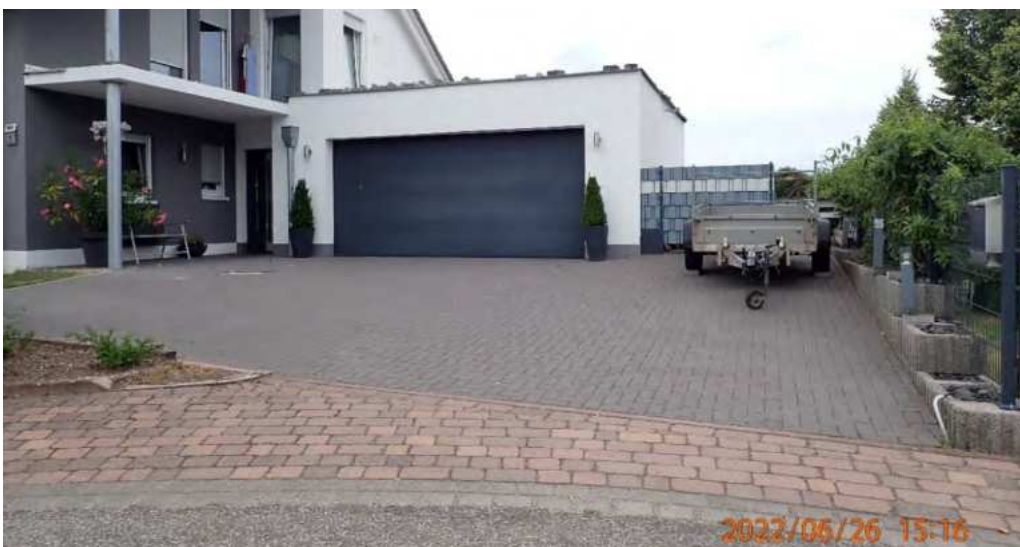
Abb. 30: Beispiel für eine zur Straße entwässernde, versiegelte Hoffläche
