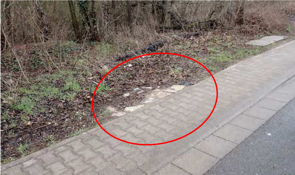
Abb. 51: Regenrückhaltebecken und oberirdischer Zulauf
