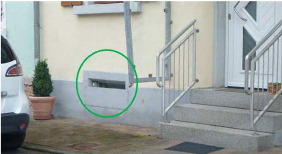
Abb. 18: Beispiele für die Sicherung tiefliegender Fenster
