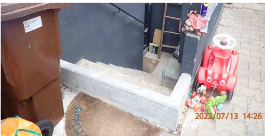
Abb. 19: Beispiel für die Sicherung eines außenliegenden Kellerzugangs
