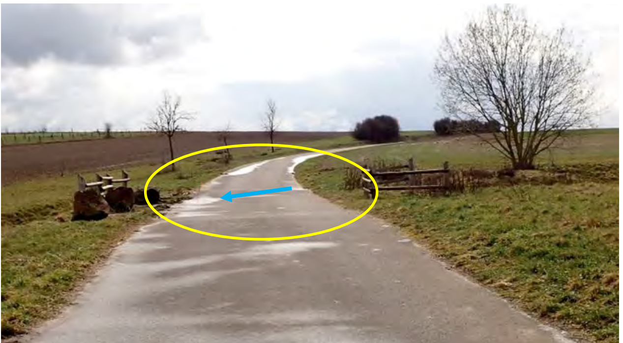
Abb. 39: Überfahrbare Furt im Wirtschaftsweg
