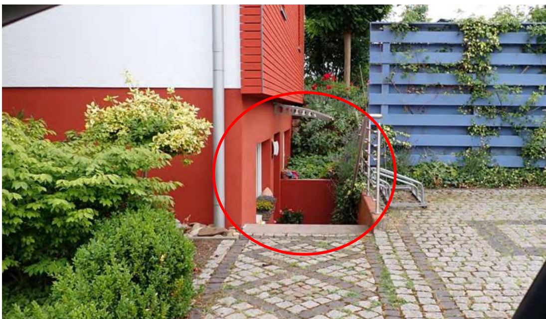
Abb. 31: Beispiele für überflutungsgefährdete Bauweise
