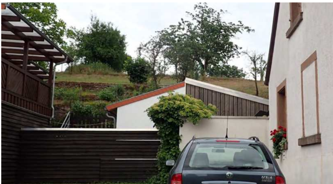
Abb. 65: Beispiel für potenziell überflutungsgefährdete Bebauung in der mittleren Steinstraße
