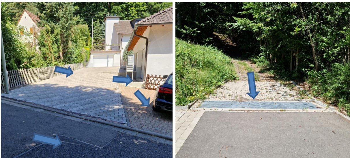
Abbildung 188: Gebäude in der Tiefenlinie (links), Waldweg mit Sandfang oberhalb Eckwiesenstraße (rechts)
