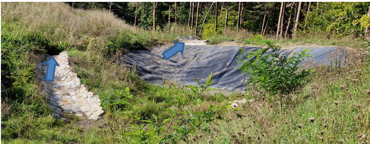
Abbildung 193: Rückhaltebecken am Parkplatz nahe Cyriakus Kapelle (an K 16)
