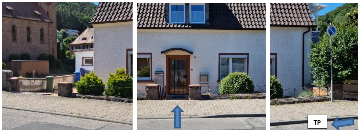
Abbildung 208: Gebäude im Tiefpunkt Wiesenstraße
