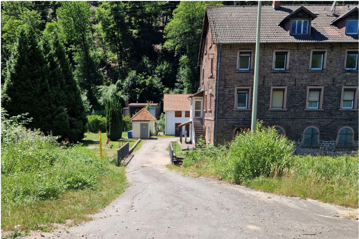
Abbildung 182: Überflutungsbereich bei "Neue Maschine"
