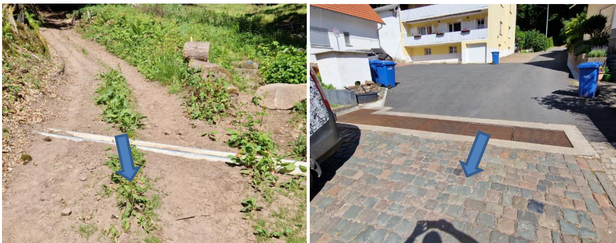
Abbildung 206: vorh. Querschlag als Metallrinne oberhalb Joppenholzstraße (links), Sandfang am oberen Ende der Joppenholzstraße (rechts)
