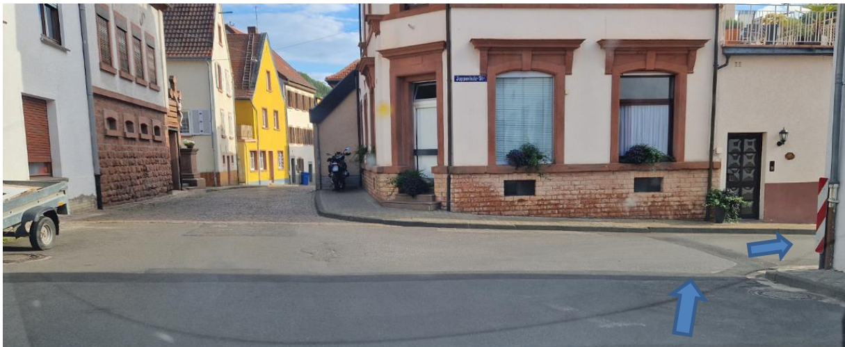
Abbildung 197: Kreuzungsbereich Joppenholzstraße / Hauptstraße
