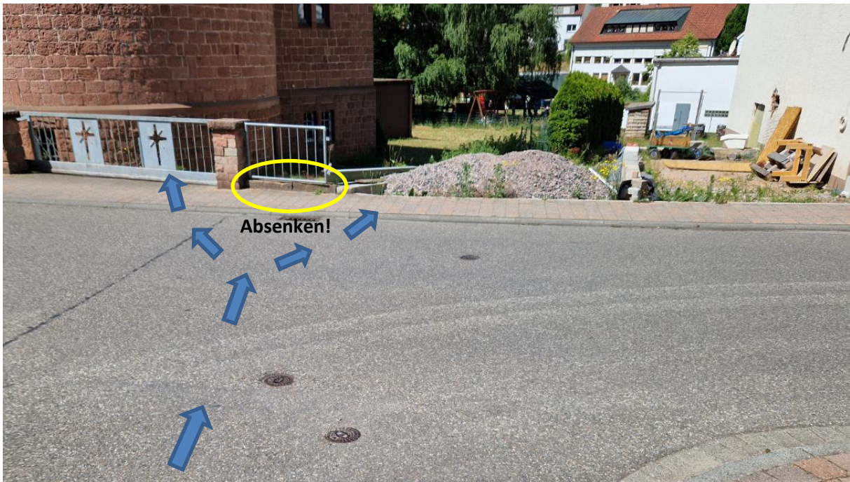
Abbildung 204: leichter Tiefpunkt in der Hauptstraße unterhalb Karlstraße / Neutalstraße
