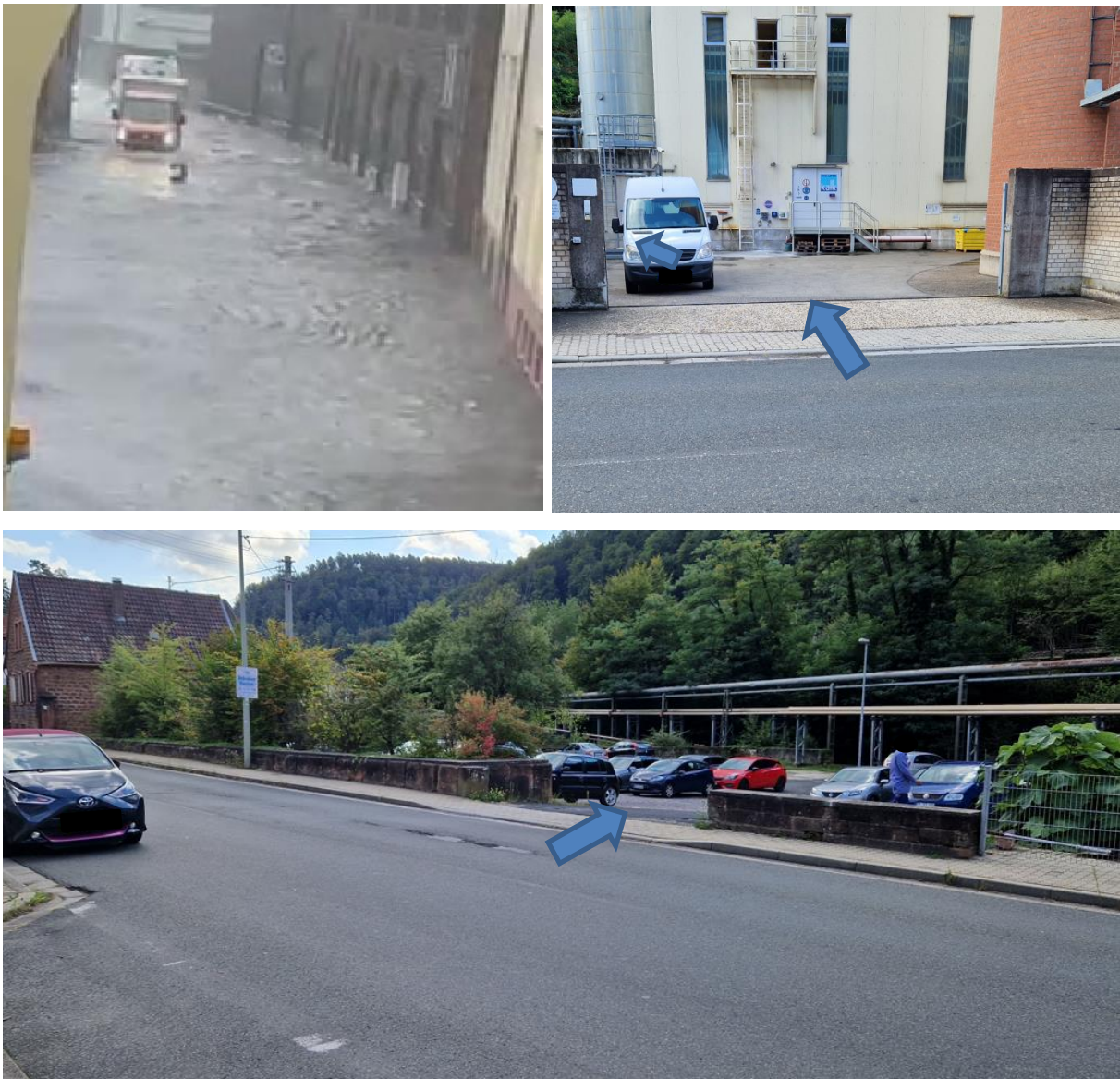
Abbildung 159: Hochwasser vor Firma Glatz bei vergangem Ereignis (oben links); Durchlass zwischen Firmengebäude der Fa. Glatz als Abfluss für TP-Bereich (oben rechts); Weiterer möglicher Abfluss Richtung Hochspeyerbach (unten)
