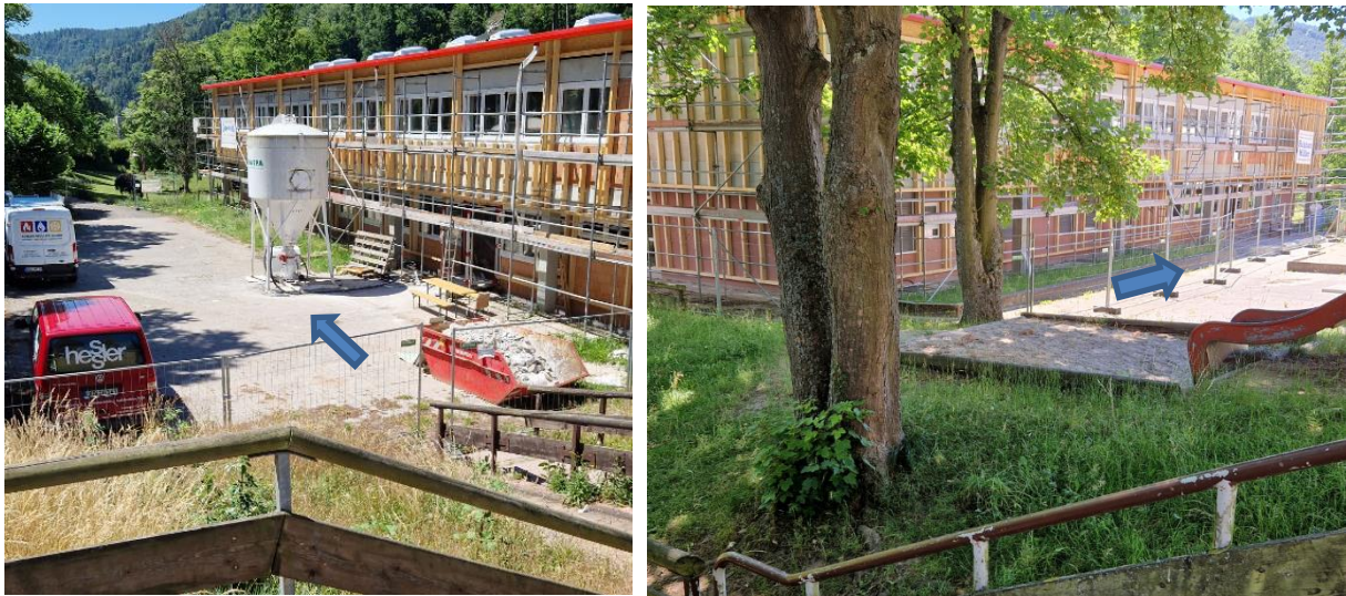
Abbildung 212: östliches Schulgelände (links), westliches Schulgelände (rechts)
