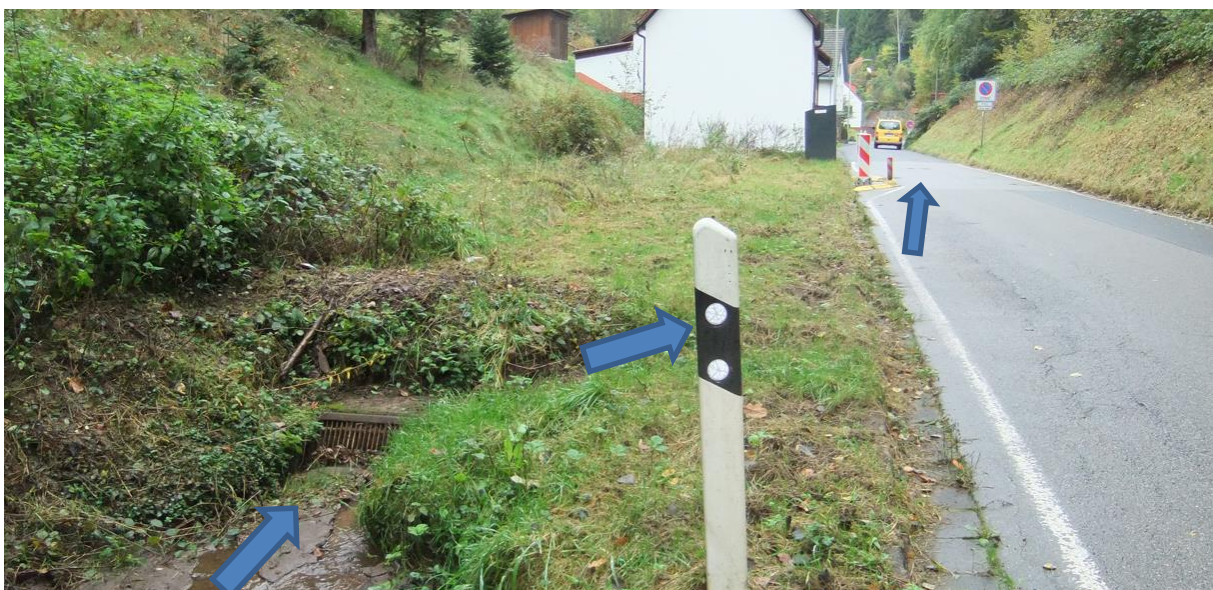
Abbildung 85: Blick auf Einlaufbauwerk Haselbach
