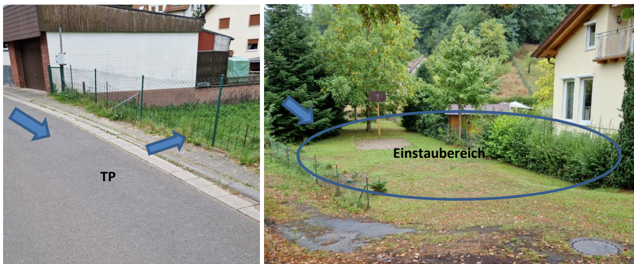
Abbildung 86: Tiefpunktbereich Hasselbachstraße (links), tiefliegender Bereich Bahnhofstraße (rechts)
