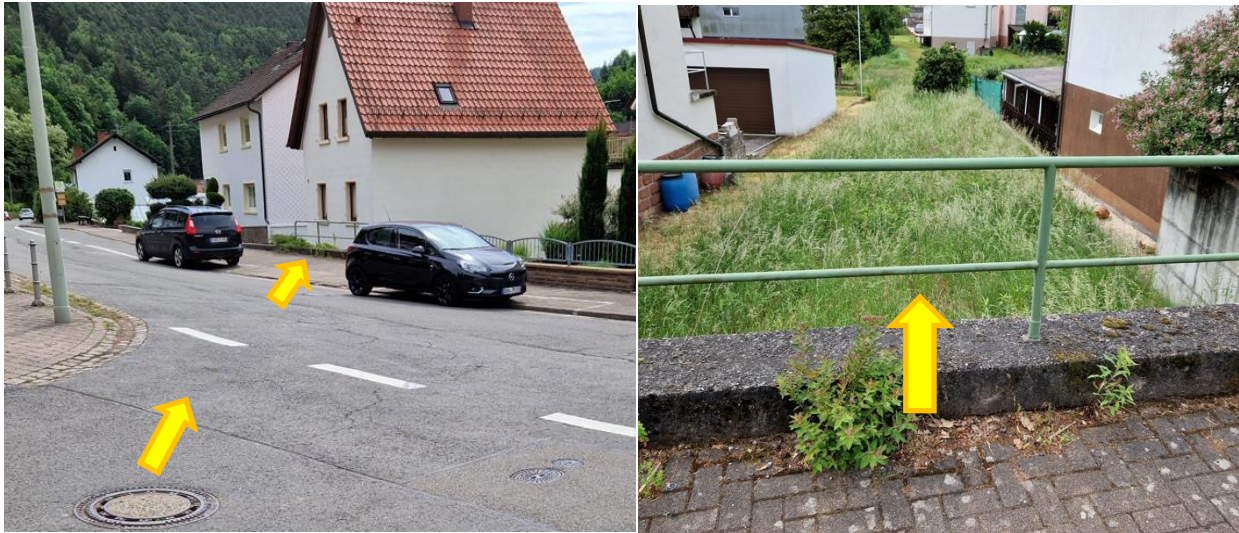
Abbildung 96: Alternativer NA-Weg mit neuem TP im Zuge einer Straßenneumodellierung (links), frei liegender Grünstreifen als potentieller NA-Weg (rechts)
