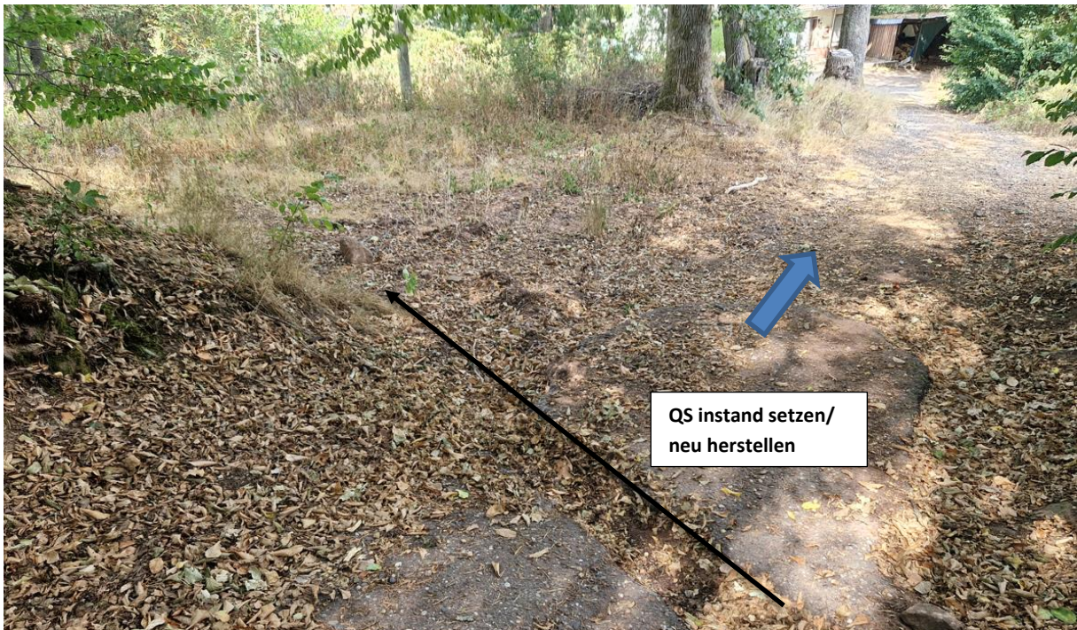
Abbildung 76: Funktionsunfähiger Querschlag im Hohlweg
