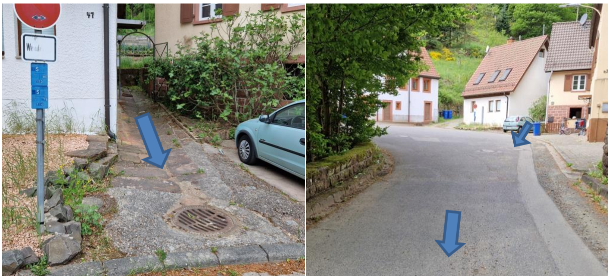
Abbildung 64: Einfallende Talkerbe im Bereich des Wendeplatzes Esthaler Straße
