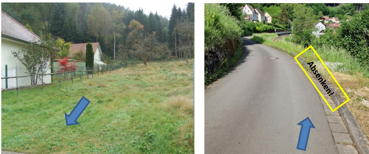
Abbildung 80: Blick zu Außengebiet oberhalb Konrad-Haag-Straße (links), Bordsteinanlage Richtung Bahn (rechts)
