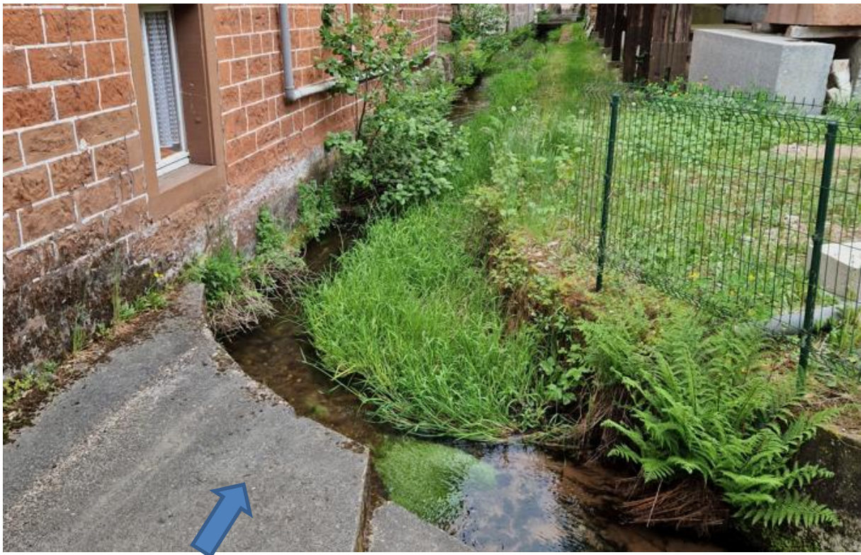
Abbildung 69: Mühlgraben als Notabflussweg im Taltiefpunkt Talstraße
