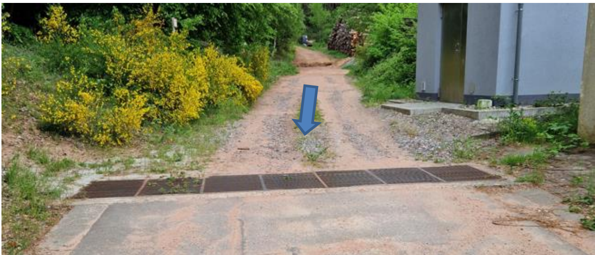
Abbildung 61: Forstweg mit Sandfang oberhalb Tannenweg
