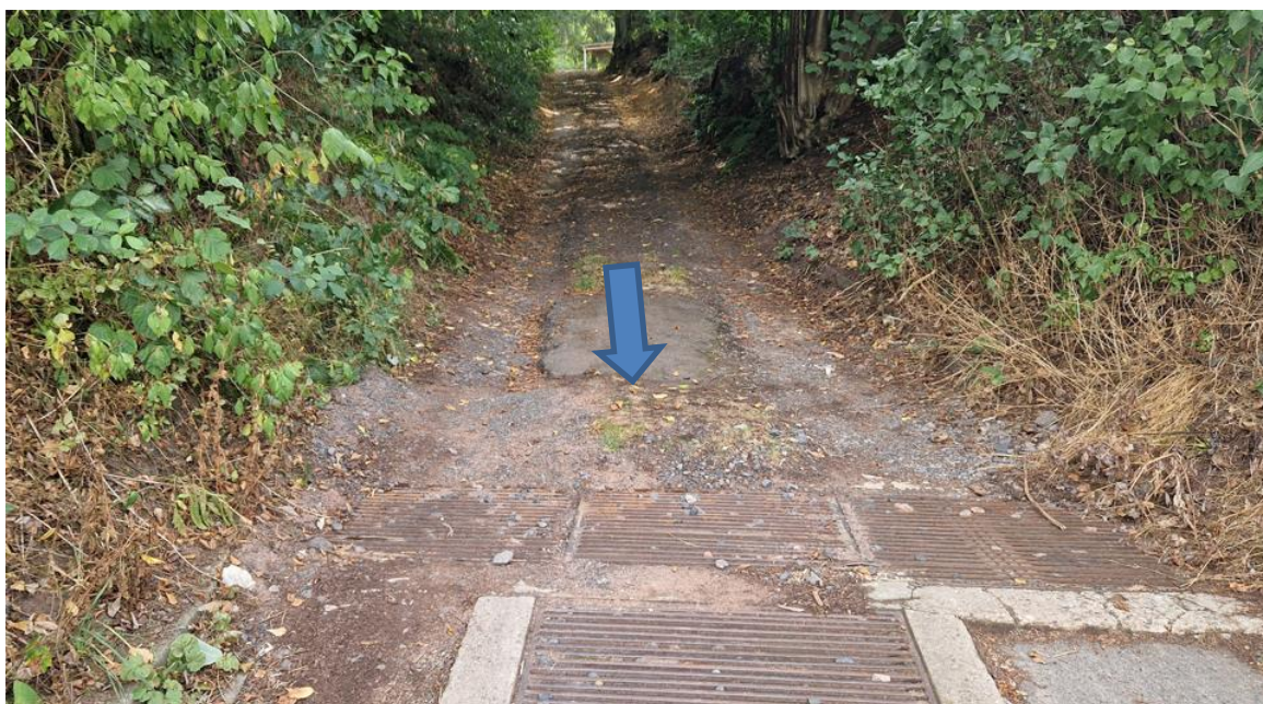
Abbildung 73: unteres Ende des Hohlwegs oberhalb Konrad-Haag-Straße mit vorhandenem Sandfang
