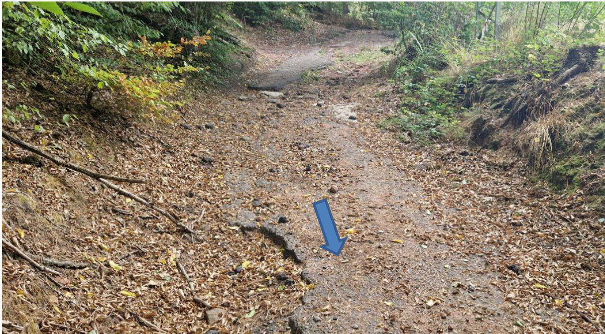
Abbildung 74: Hohlweg mit deutlichen Erosionsspuren infolge hoher Fließgeschwindigkeiten
