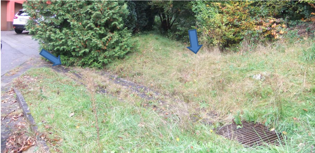
Abbildung 94: Einlaufbauwerk am oberen Ende der Friedhofstraße
