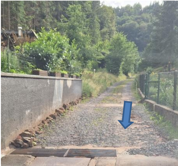
Abbildung 118: Sandfang am Ausbauende der Ortsstraße (links), Bereich für potentielle Mulden (rechts)
