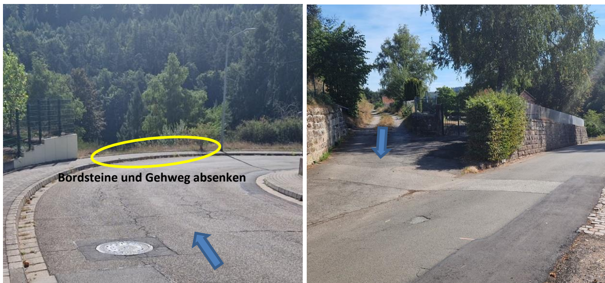
Abbildung 132: Notabflussweg im Kurvenbereich Dorfstraße oberhalb Friedhof (links), Abflussbereich unterhalb Friedhof durch Abflusslenkung oberhalb (rechts)
