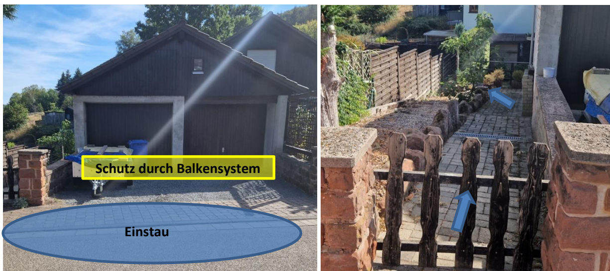
Abbildung 138: Garage im Tiefpunkt (links), Abflussweg neben Garage (rechts)
