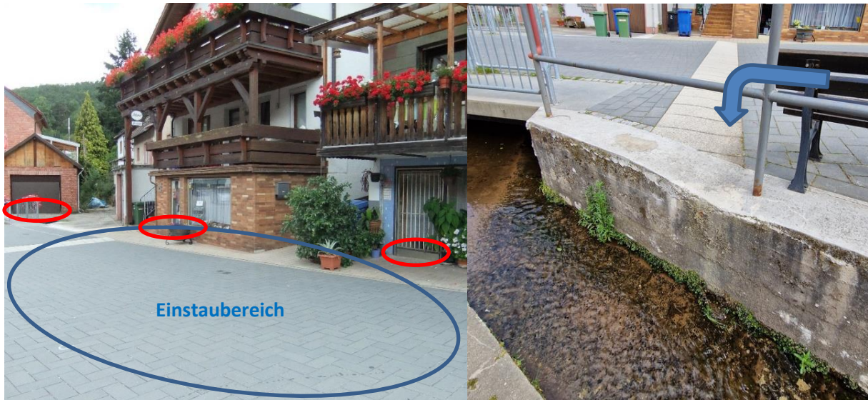
Abbildung 131: Tiefpunktbereich mit gefährdeten Gebäuden (links), Zufluss zum Iggelbach (rechts)
