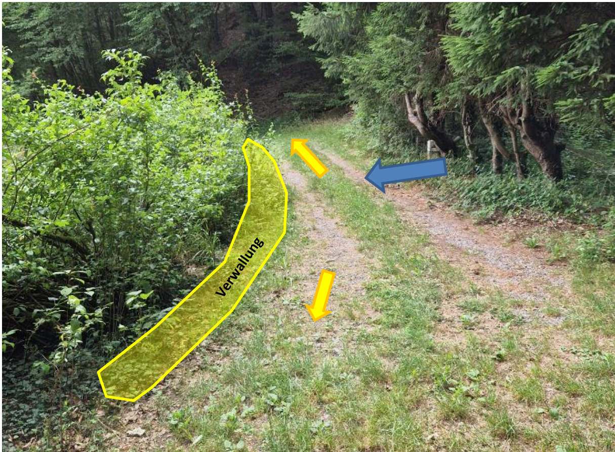
Abbildung 143: Überströmbereich des Wegedamms mit angedeuteter Erdverwallung
