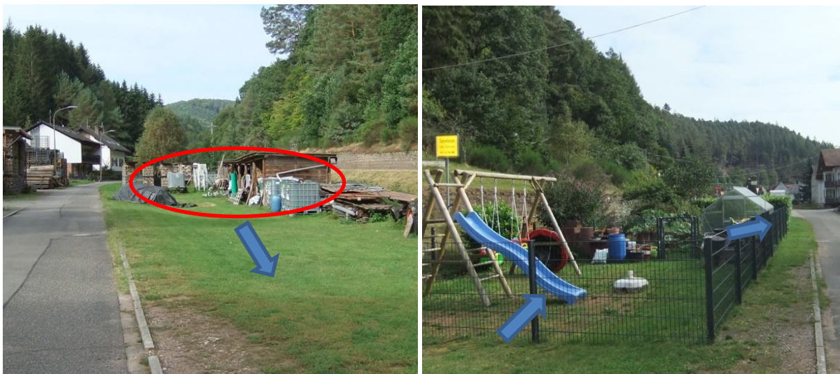
Abbildung 108: Abflusshindernis in Tiefenlinie / Notabflussweg (links), Übertrittsbereich des Wassers zur Ortsstraße (rechts)
