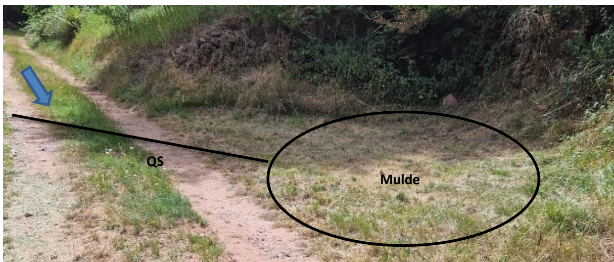
Abbildung 115: Mögliche Position für Querschlag mit Mulde entlang des Forstwegs
