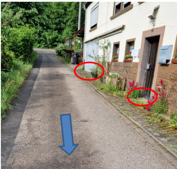
Abbildung 103: Notabflussweg mit tief liegender Gebäudeöffnung (links), Einlauf in Gewässerverrohrung (rechts)
