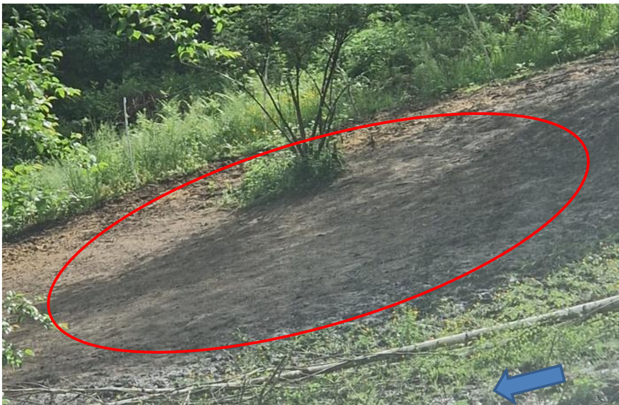
Abbildung 105: Erosionsgefährdete Weide im potentiell überflutungsgefährdeten Bereich in der Aue
