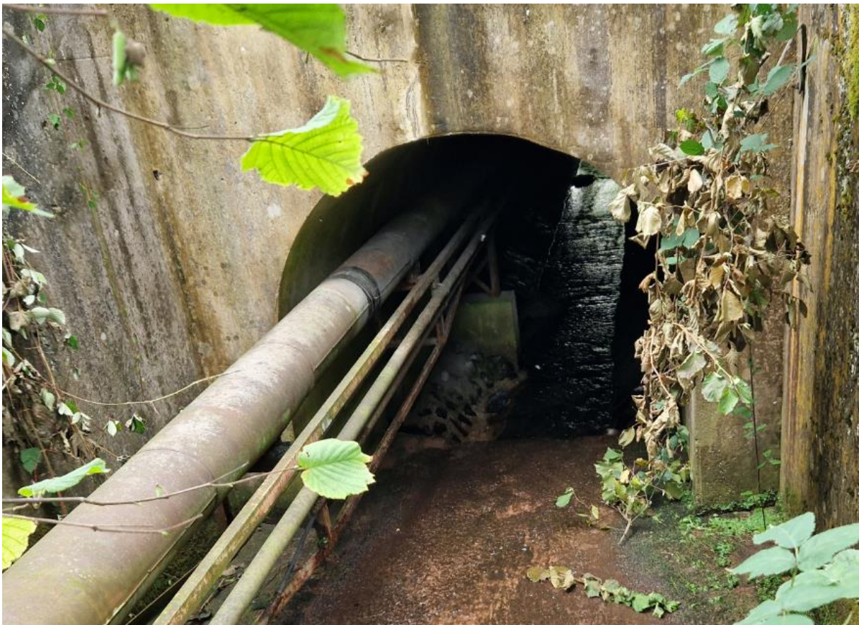
Abbildung 317: Durchlass für Weisenbach unter Bahndamm
