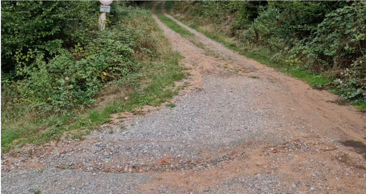
Abbildung 297: Forstweg oberhalb des „Judenackers“ mit erkennbaren Erosionsspuren und transportiertem Bodenmaterial
