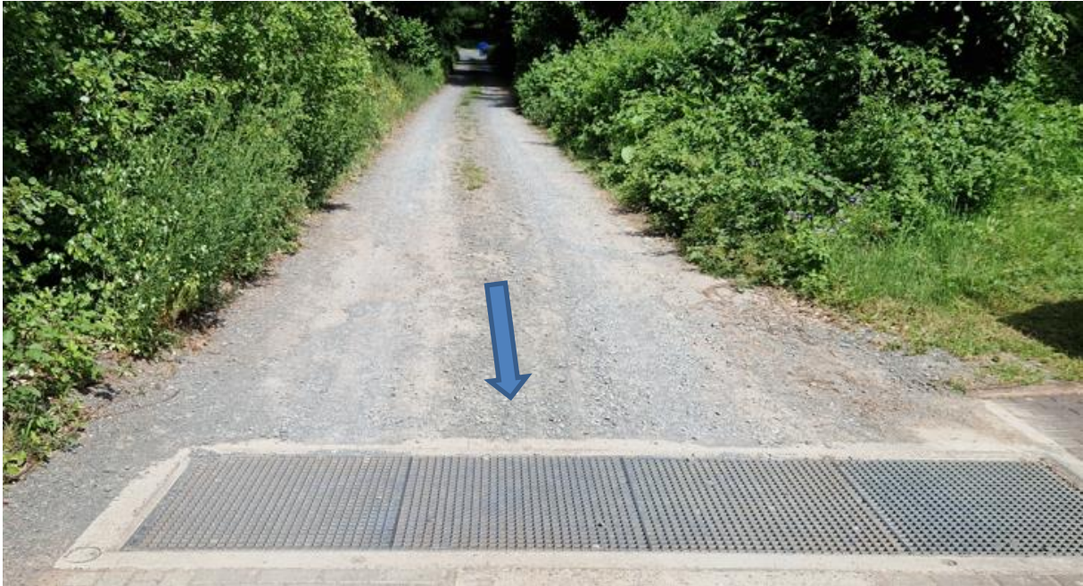
Abbildung 319: Einfallender Weg Richtung "Mainzer Tal" mit vorhandenem Sandfang
