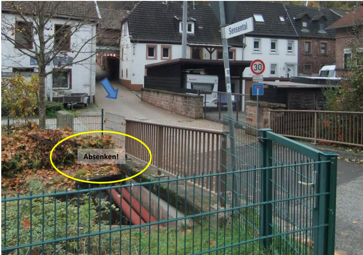
Abbildung 309: Brücke über den Hochspeyerbach im Einmündungsbereich der Sensentalstraße in die Hauptstraße
