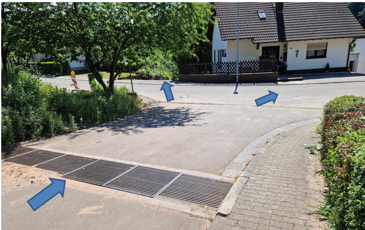
Abbildung 294: Einmündungsbereich der Waldwege in die Langecker Straße mit Blick auf Julius-Sultan-Weg
