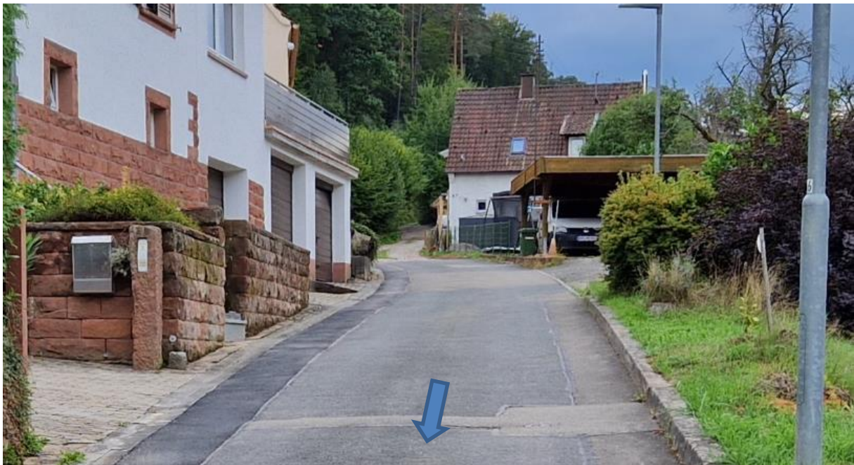
Abbildung 296: Blick auf oberes Ausbauende der Straße „Judenacker“
