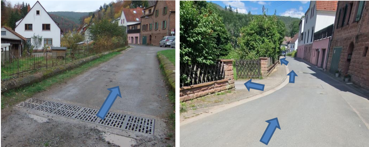
Abbildung 316: Wegedamm über Weisenbach mit Gebäude in der Tiefenlinie im Hintergrund links (links), Zutrittsmöglichkeit für Oberflächenwasser zum Grundstück Gebäude 30A (rechts)
