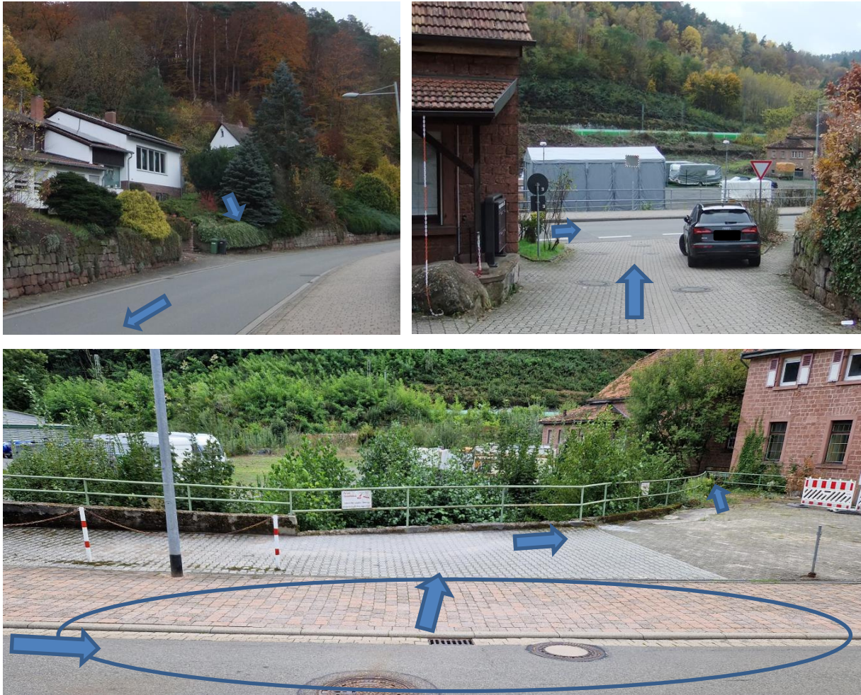
Abbildung 312: Blick auf Talkerbe zwischen Hauptstraße 211 und 213 (oben links), Einmündungsbereich „Dittsteg“ in die Hauptstraße (oben rechts), Straßentiefpunkt mit Abflussweg zum Gewässer (unten)
