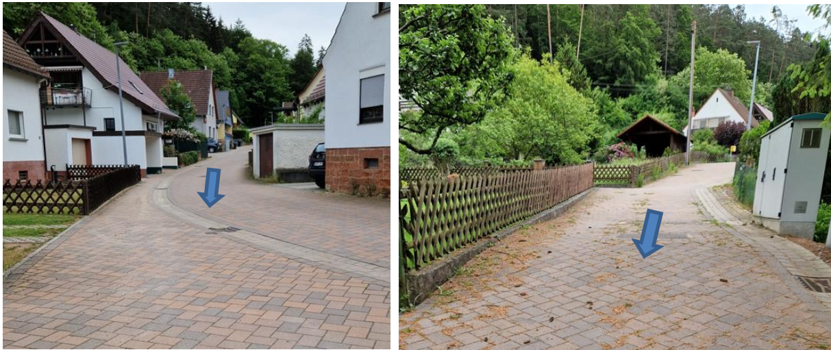
Abbildung 270: Straße Richtung südöstliches Tal (links), Straße Richtung zu nordwestlichem Ortsausgang (rechts)
