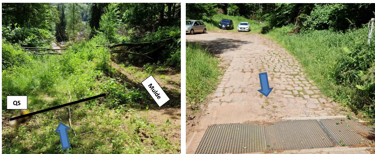
Abbildung 311: Geländemulde oberhalb „Dittsteg“ (links), Sandfang am oberen Ende „Dittsteg“ (rechts)
