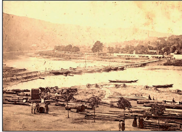
Pontonbrücke über die Mosel, 1870 erbaut. An dieser Stelle wurde 1874 eine feste Brücke errichtet.
