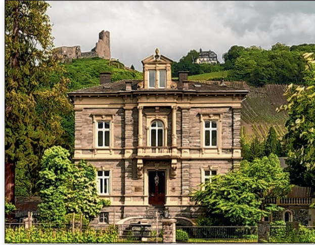
Gutshaus, Blick von der Saarallee
