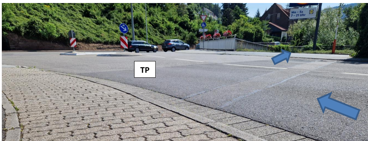
Abbildung 236: Tiefpunktbereich Beerentalstraße vor Einmündung in die Hauptstraße
