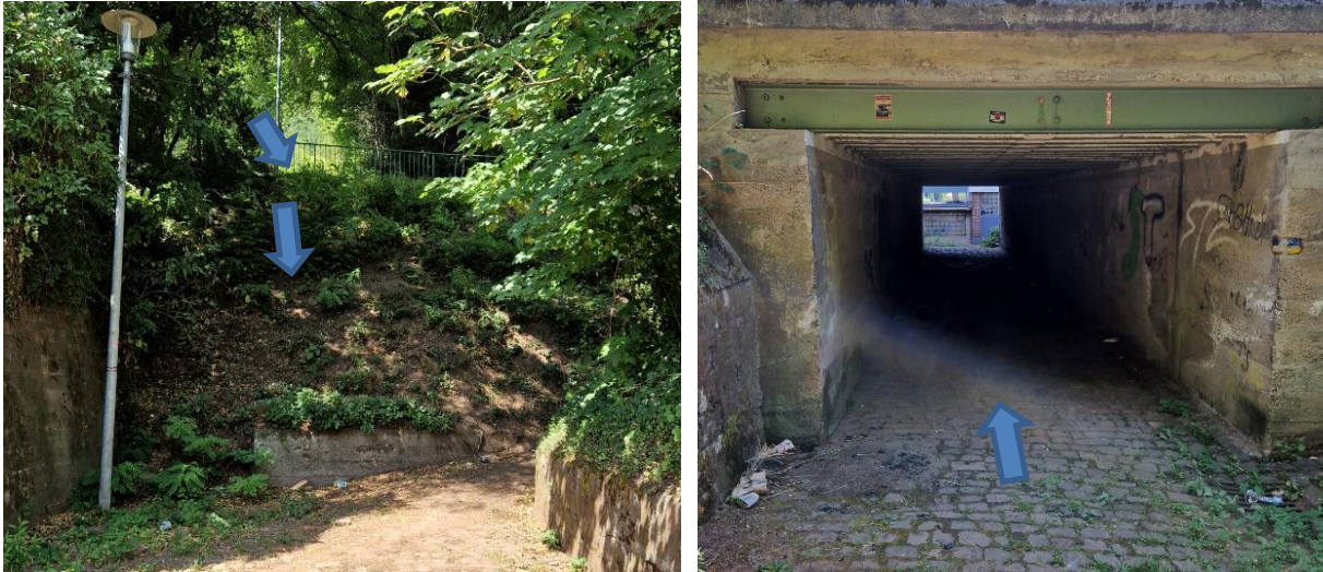
Abbildung 261: Blick Richtung Sommerbergstraße von Bahnunterführung (links), Bahnunterführung Richtung Stadtwerkegebäude (rechts)
