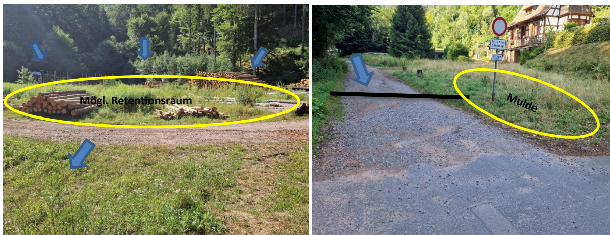
Abbildung 233: Holzplatz in der Talkerbe südlich BeerentalstraÙ als potentieller Retentionsraum (links), Oberes Ende der BeerentalstraÙe mit Möglichkeit für Mulde zum Grobstoffrückhalt (rechts)
