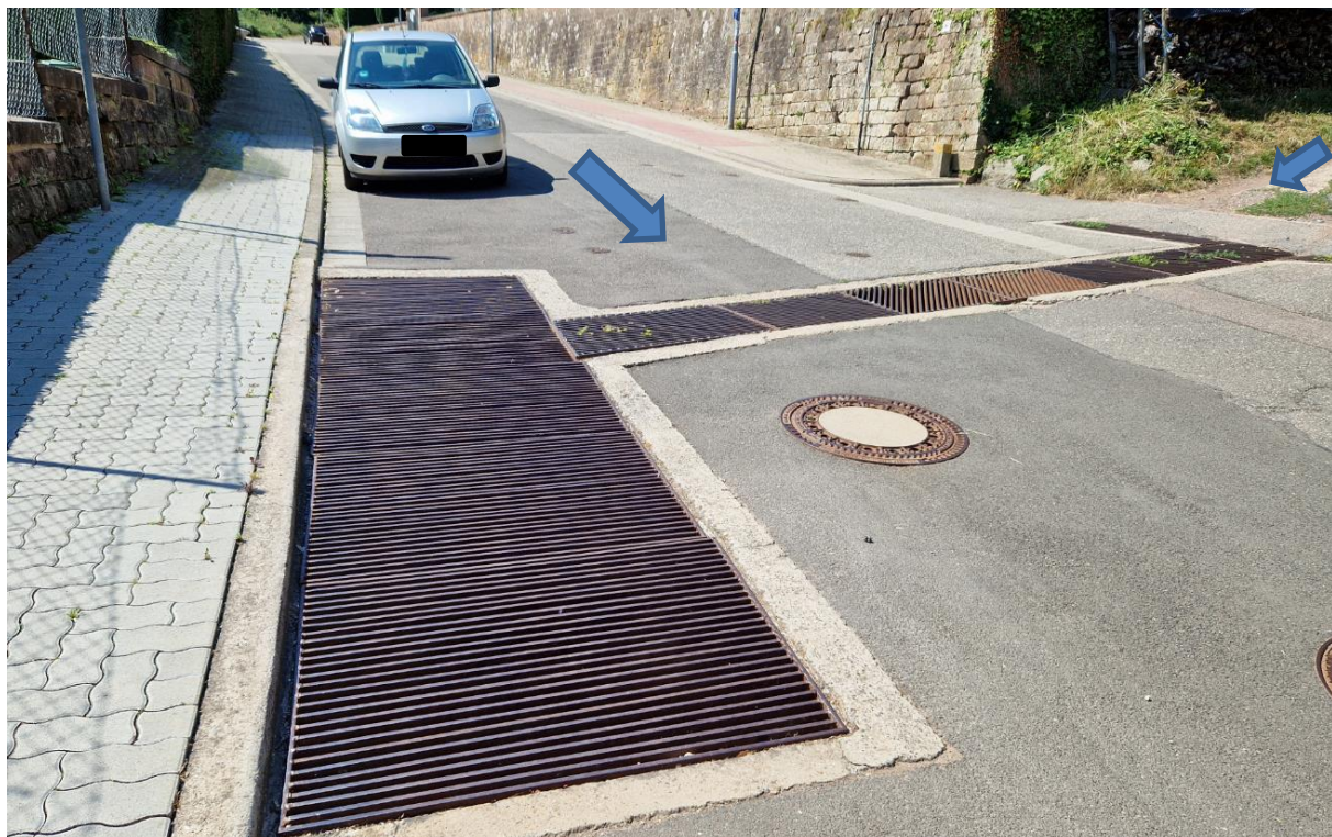
Abbildung 239: Sandfang in der Marktstraße mit seitlich einfallendem Hohlweg
