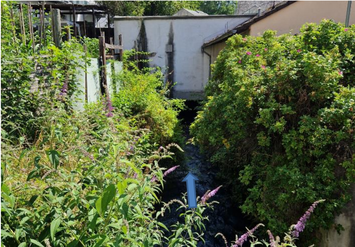
Abbildung 229: Durchlass unter Firmengebäude Fa. Marx GmbH
