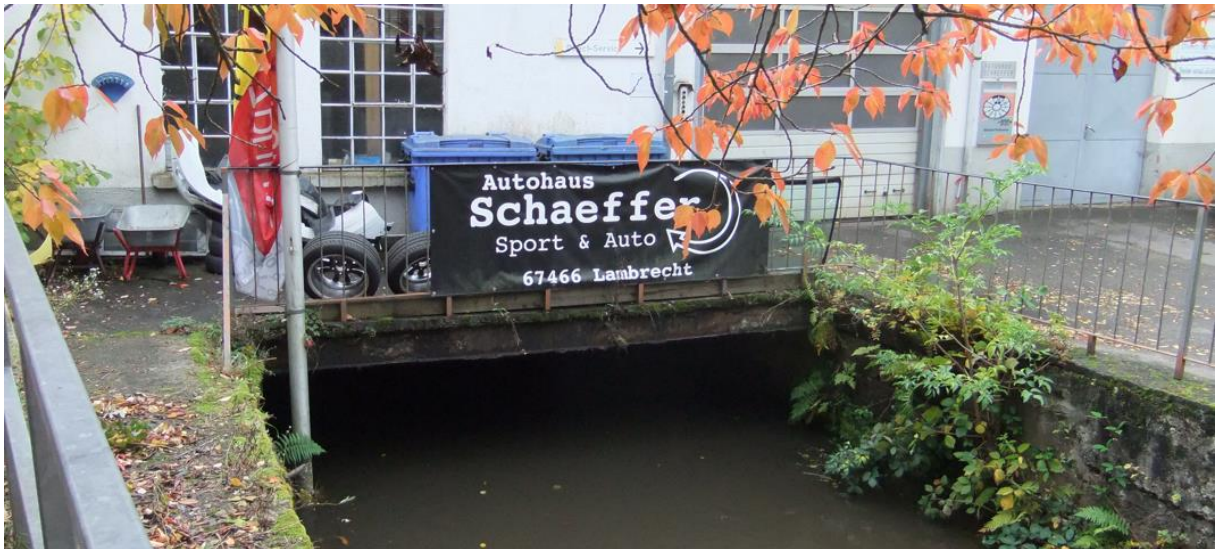
Abbildung 226: Durchlass unter Autohaus Schäffer
