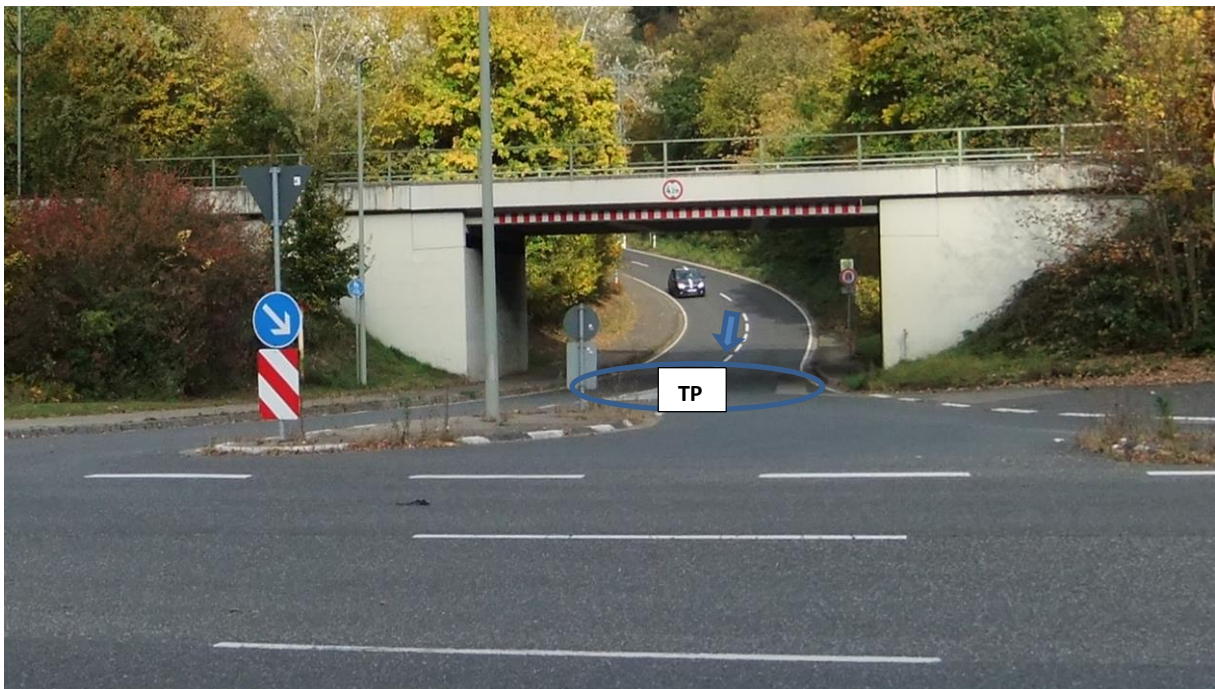
Abbildung 222: Bahnunterführung der K 16
