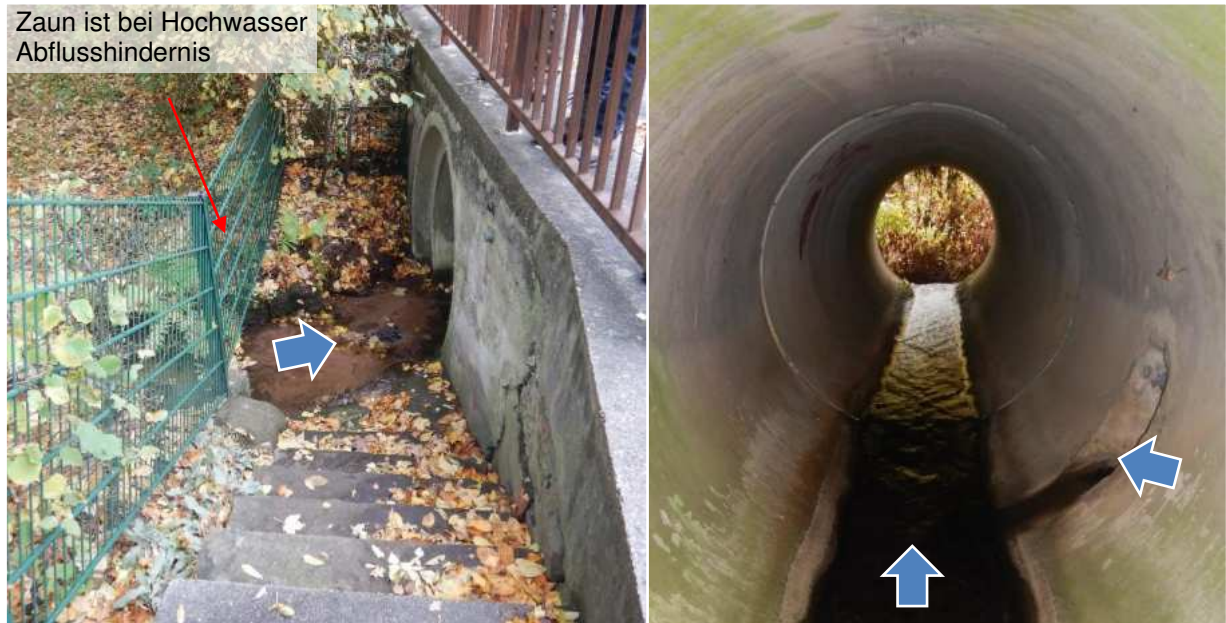
Abbildung 40 Durchlass Erlenbach unter Straße Am Erlenbach
