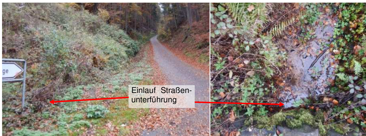
Abbildung 16 Situation Zufahrtstraße Sportplatz
