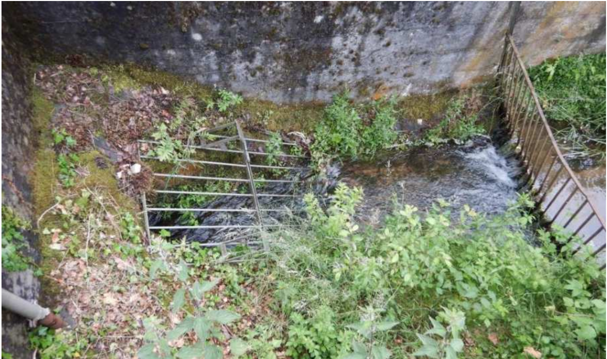
Abbildung 10 Einlauf Verrohrung Glasbach im Bereich Villa Denis
