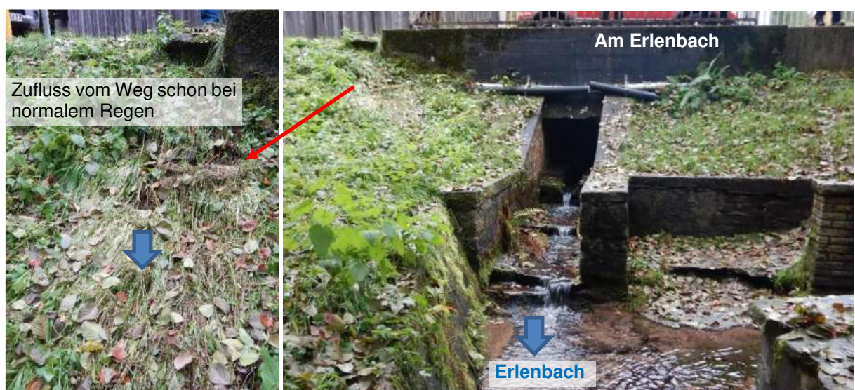
Abbildung 35 Situation Verrohrung Erlenbach Kistenfabrik (Am Erlenbach 33)
