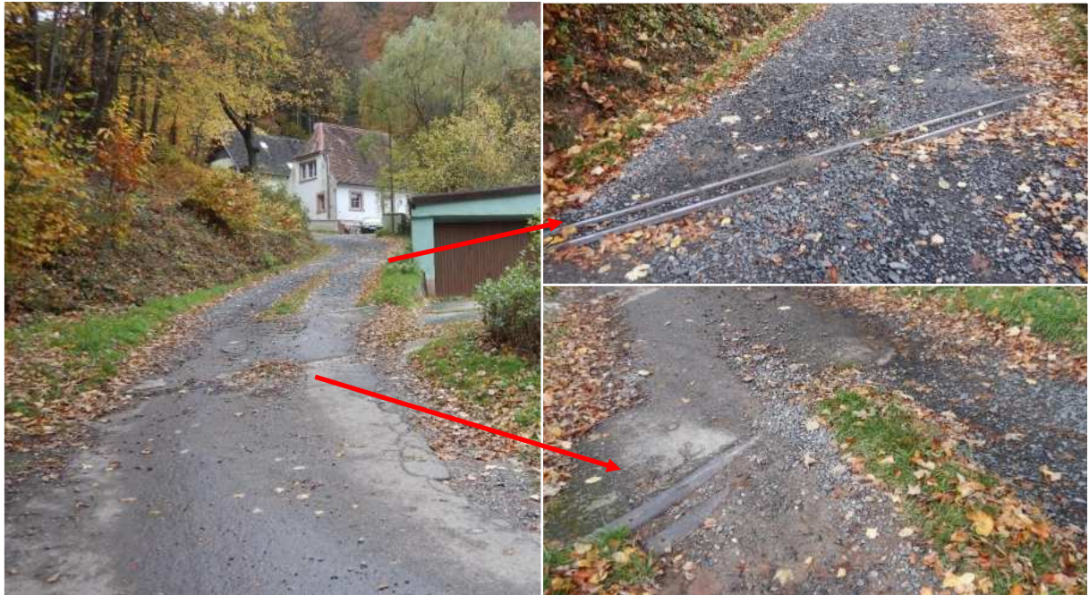
Abbildung 44 Spechtental Situation Zufahrt, nicht funktionsfähige Querabschläge
