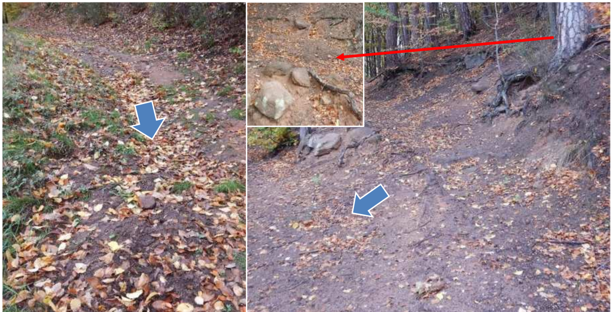
Abbildung 43 Erosion in Wegen und an den Hanglagen im Spechtental
