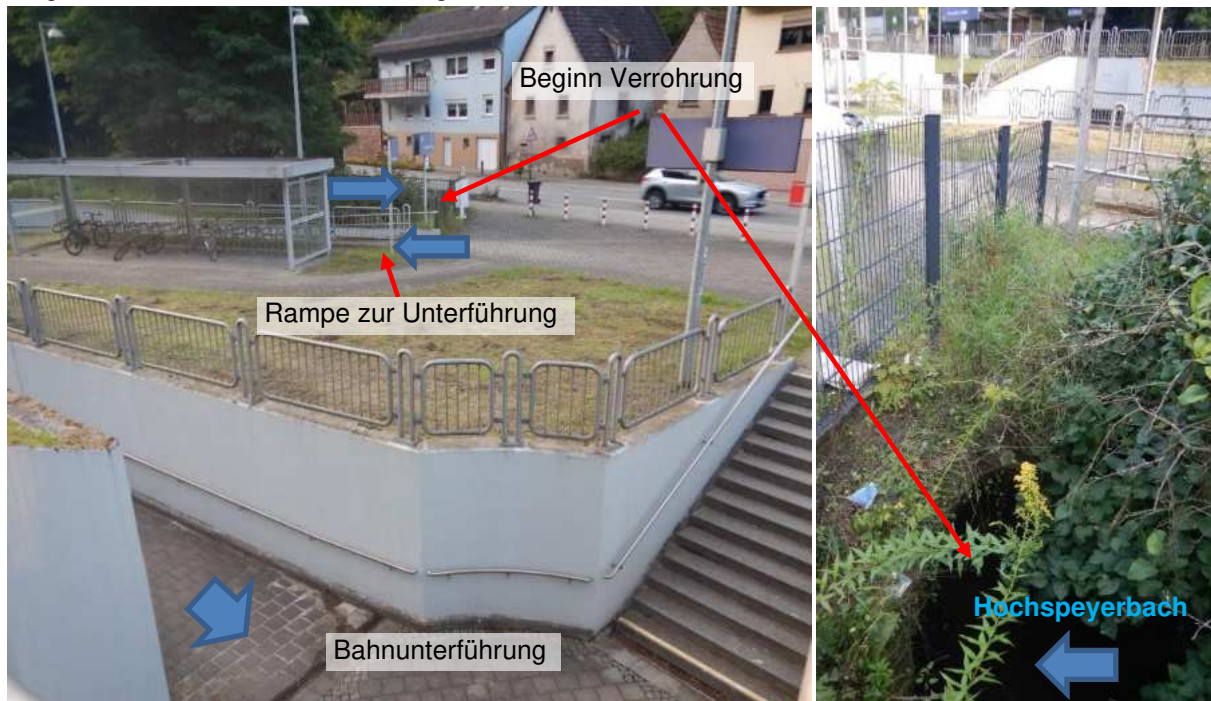
Abbildung 20 Beginn Bachverrohrung Hochspeyerbach vor Bahnhof, Unterführung
