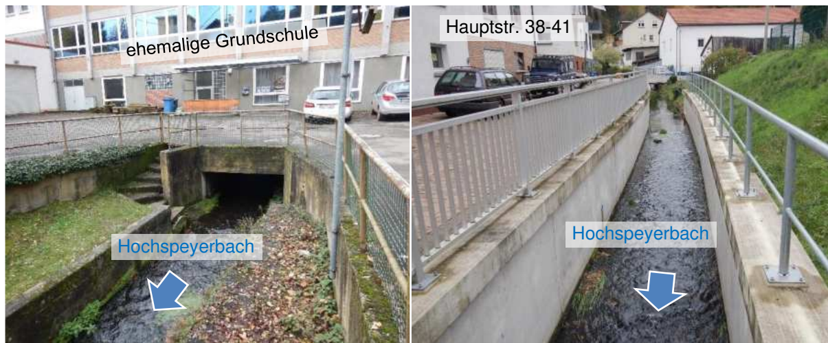
Abbildung 25 Situation Hochspeyerbach Bereich ehemalige Grundschule
