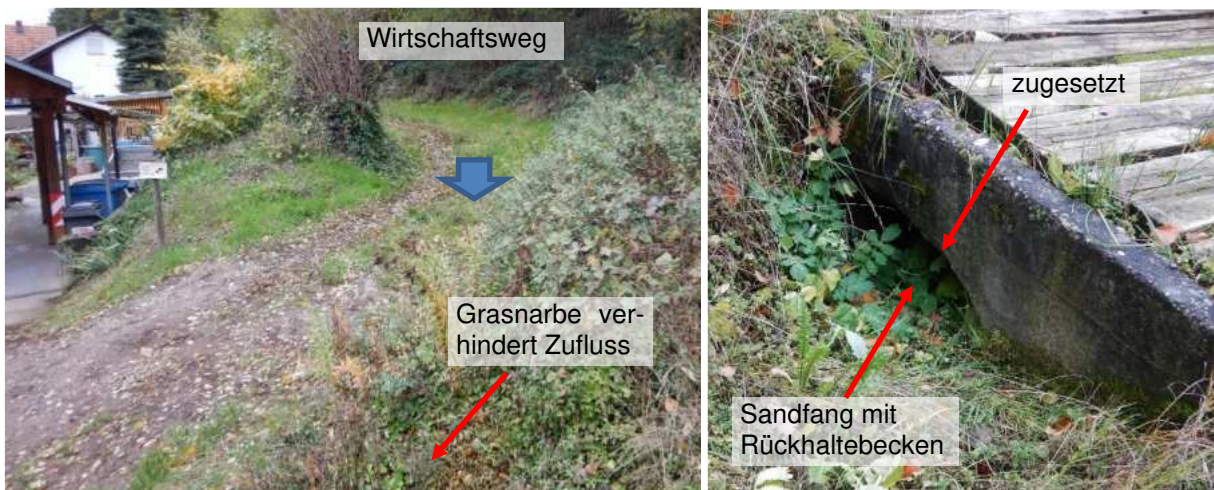
Abbildung 38 Situation Einmündung Wirtschaftsweg / Waldweg auf Am Galgental oberhalb Nr. 33
