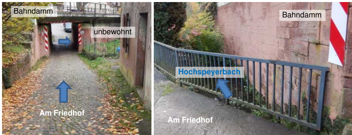
Abbildung 28 Situation Bahnunterführung, Am Friedhof, Abschlag Hochspeyerbach
