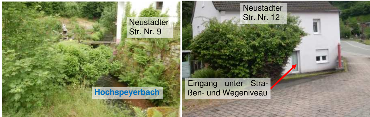
Abbildung 48 Situation Neustadter Straße Nr. 9 und 12
