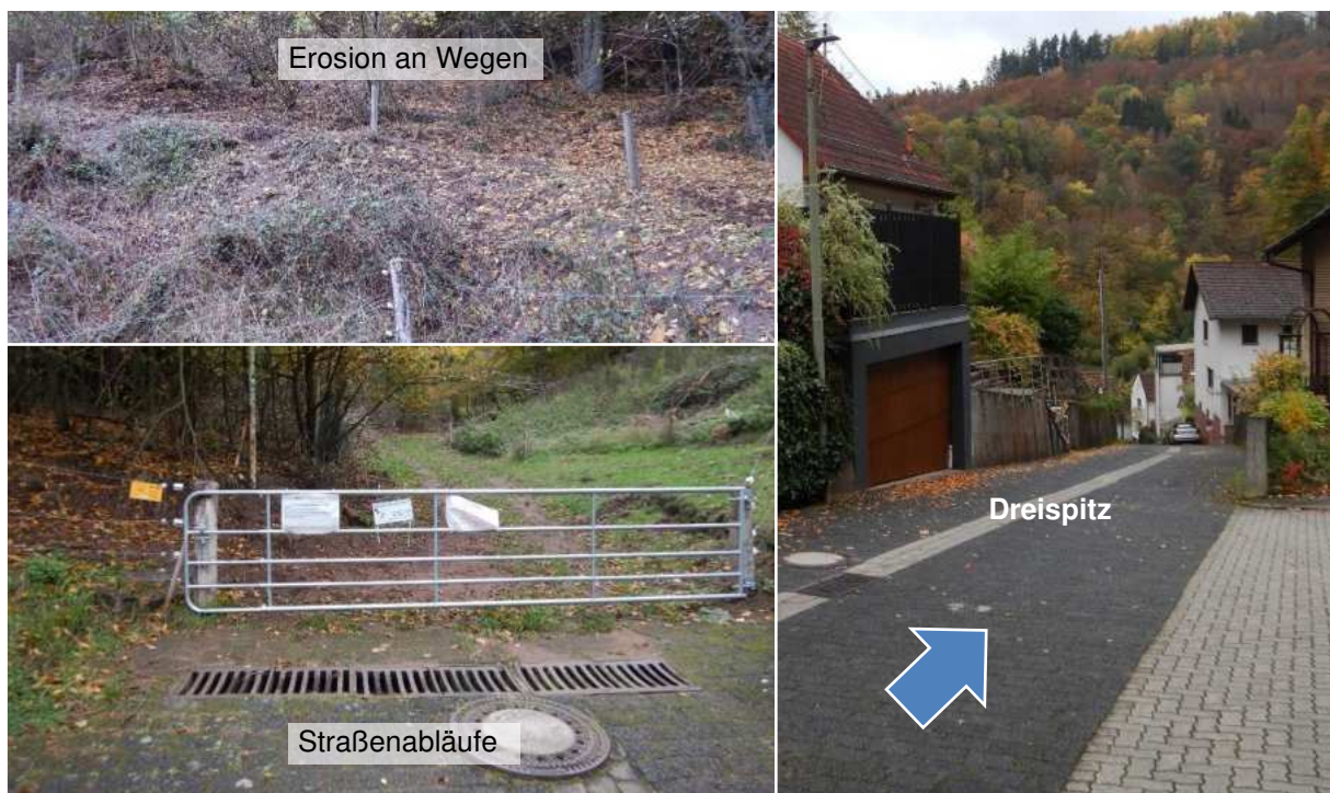
Abbildung 23 Situation Straße Dreispitz
