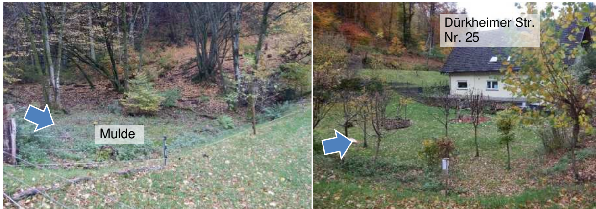
Abbildung 45 Mulde oberhalb der Bebauung im Spechtental
