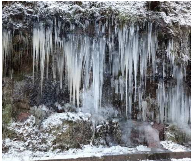
Abbildung 12 durch Schichtenwasser entstehende Eiszapfen im Bereich der Villa Denis
